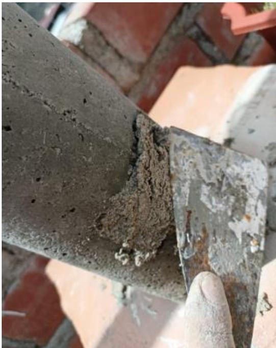
Fotografía N°30. Reparación de vacíos con mortero polimérico diseño N°1.
