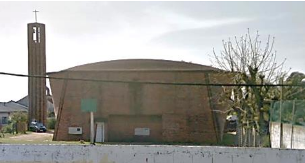
P or el Norte: Fachada vista desde la Ca. El Taruman
