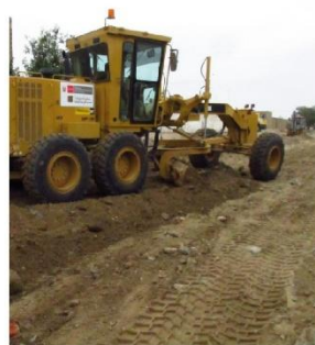
Maquinaria nivelando avenidas principales.
