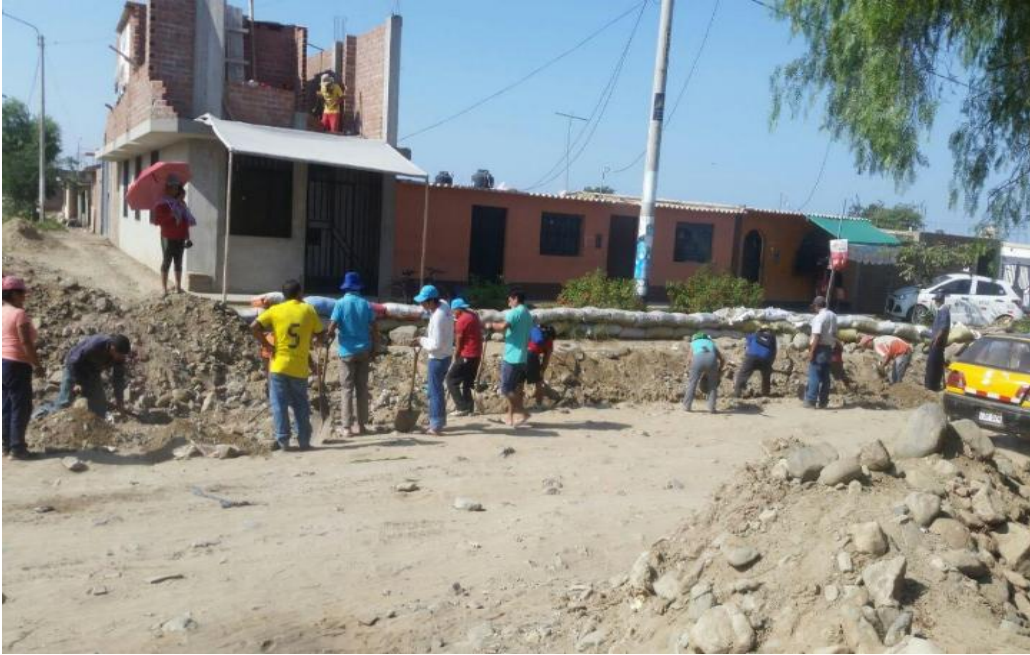
Pobladores Virgen del Socorro realizando zanjas para la conexión del agua por pileta.
