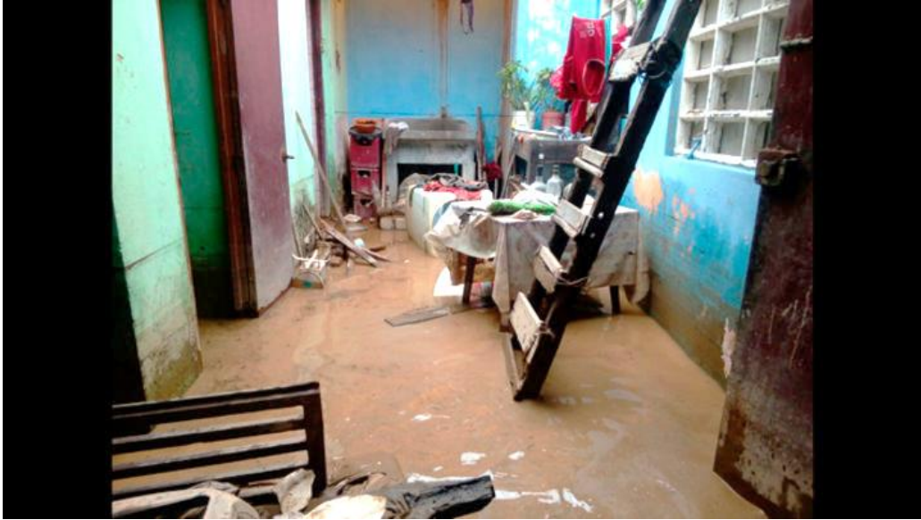
Casas inundadas por lluvias y huaycos
