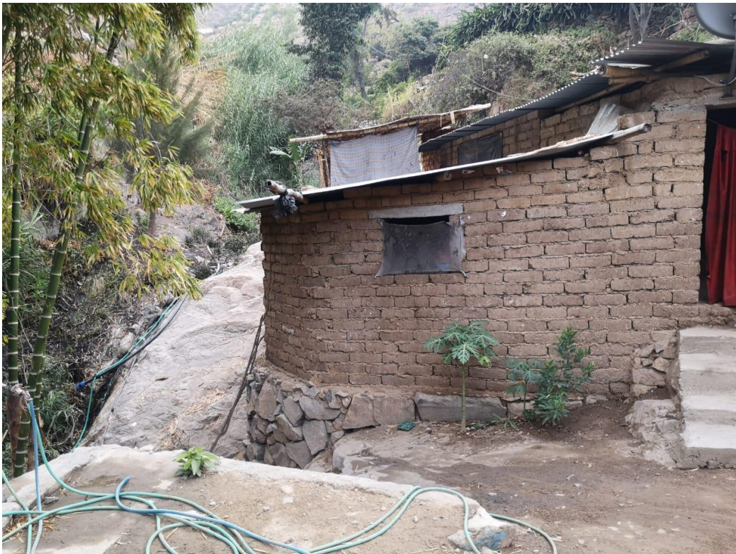
No existe conexiones domiciliarias adecuadas para las viviendas.
