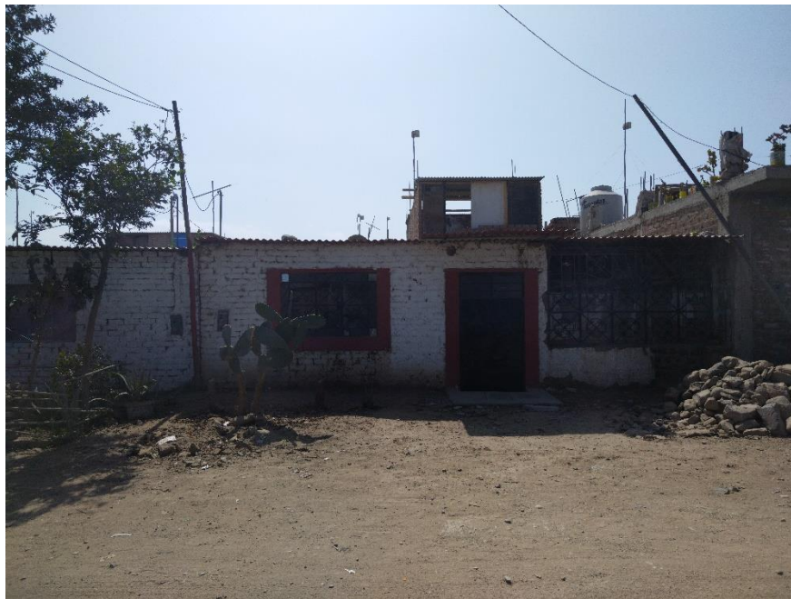
Elaboración Propia. Vivienda construida en ladrillo crudo
