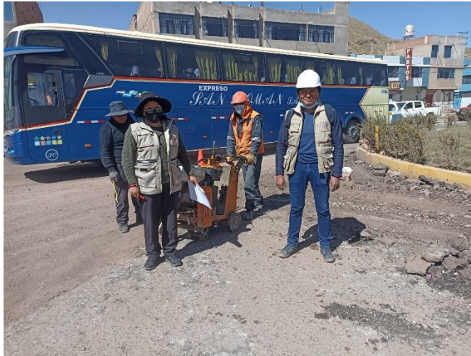
Figura 6. Vista de instalación de equipo de corte.
