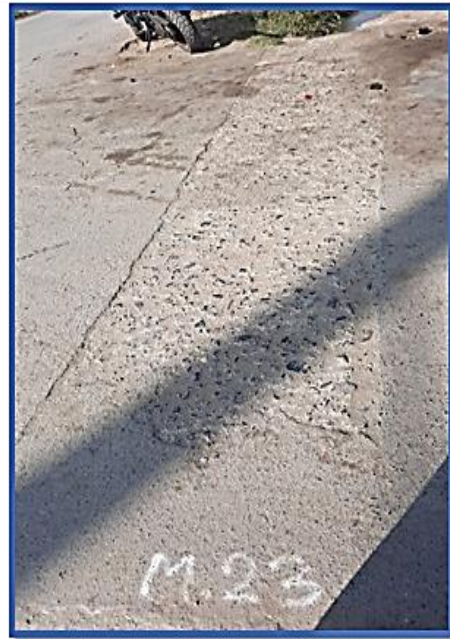
FOTOGRAFIA N° 18: PARCHEO Y PULIMENTO DE AGREGADOS.
