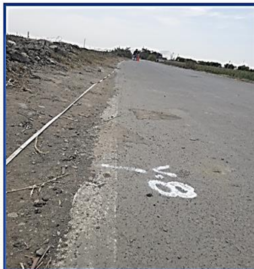
FOTOGRAFIA N° 4: SEÑALIZACIÓN DEL TAMAÑO DE MUESTRA DE 100 ml PARA VIZIR.
