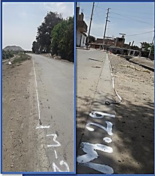
FOTOGRAFIA N° 1: SEÑALIZACIÓN DE TAMAÑOS DE MUESTRA SEGÚN PCI.
