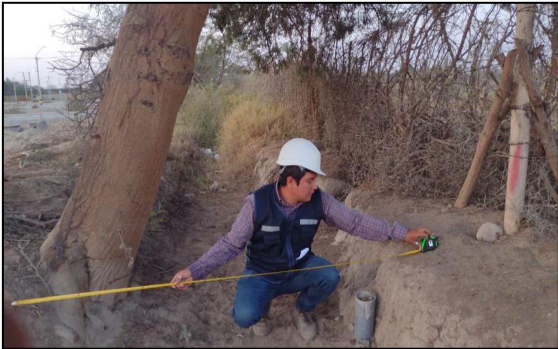
Figura.41 Toma de las medidas de las secciones del canal.
