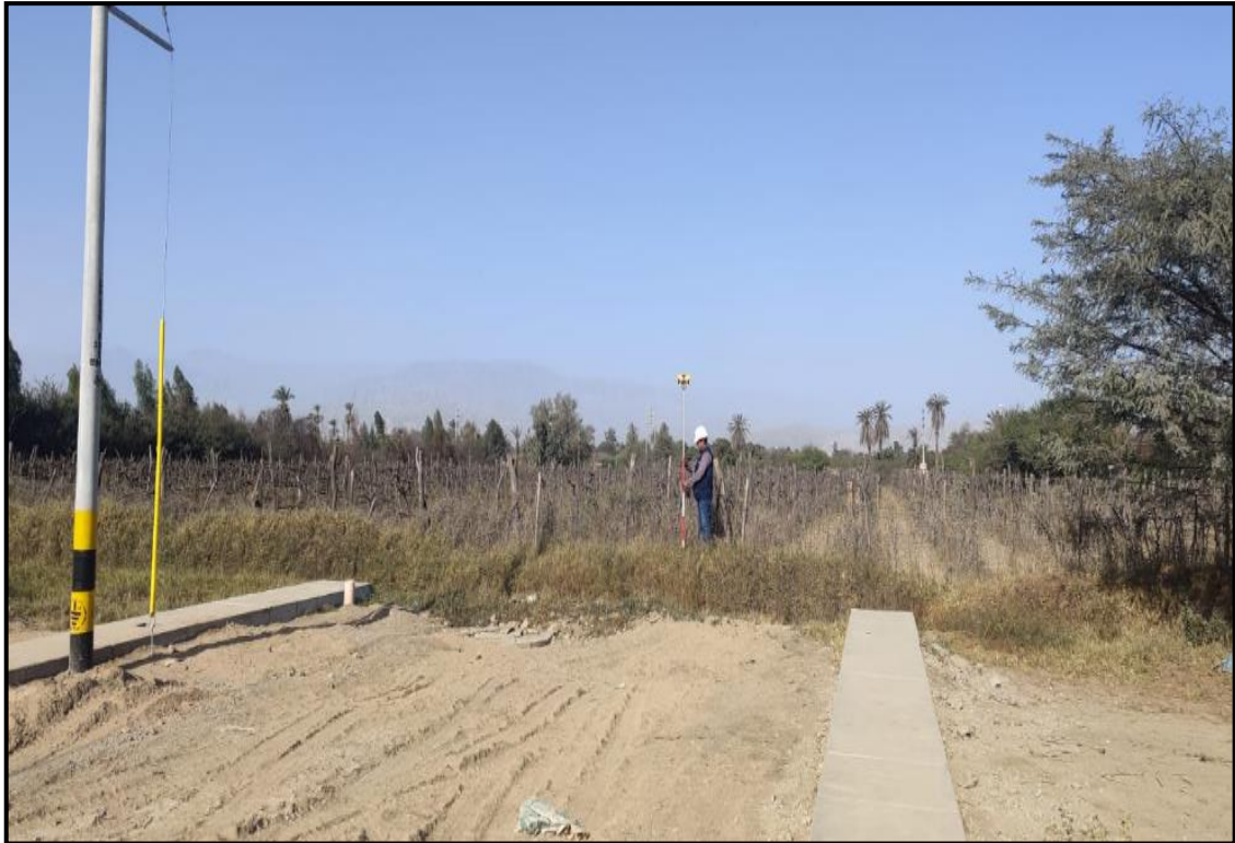
Figura.48 Se observa la toma de las secciones del canal durante el levantamiento topográfico.
