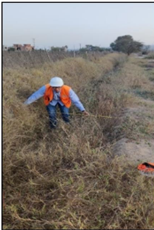
Figura.51 Toma de medias de las secciones del canal.
