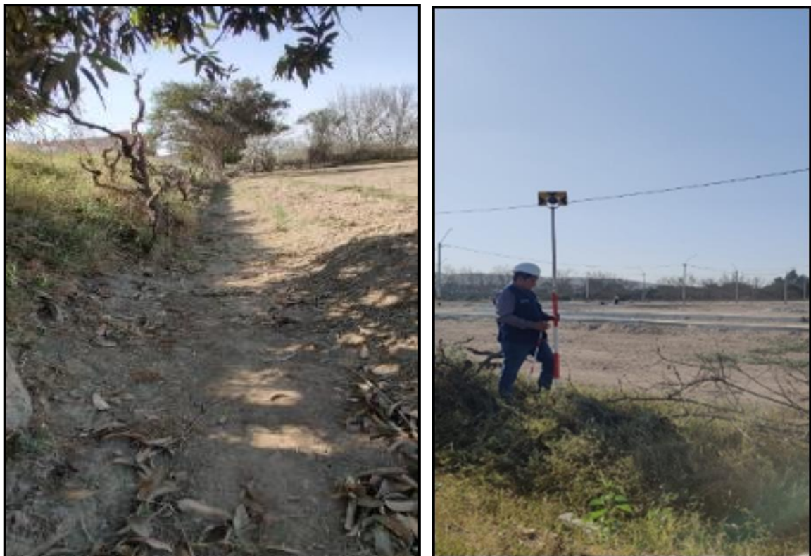
Figura.48 Se observa la toma de las secciones del canal durante el levantamiento topográfico.
