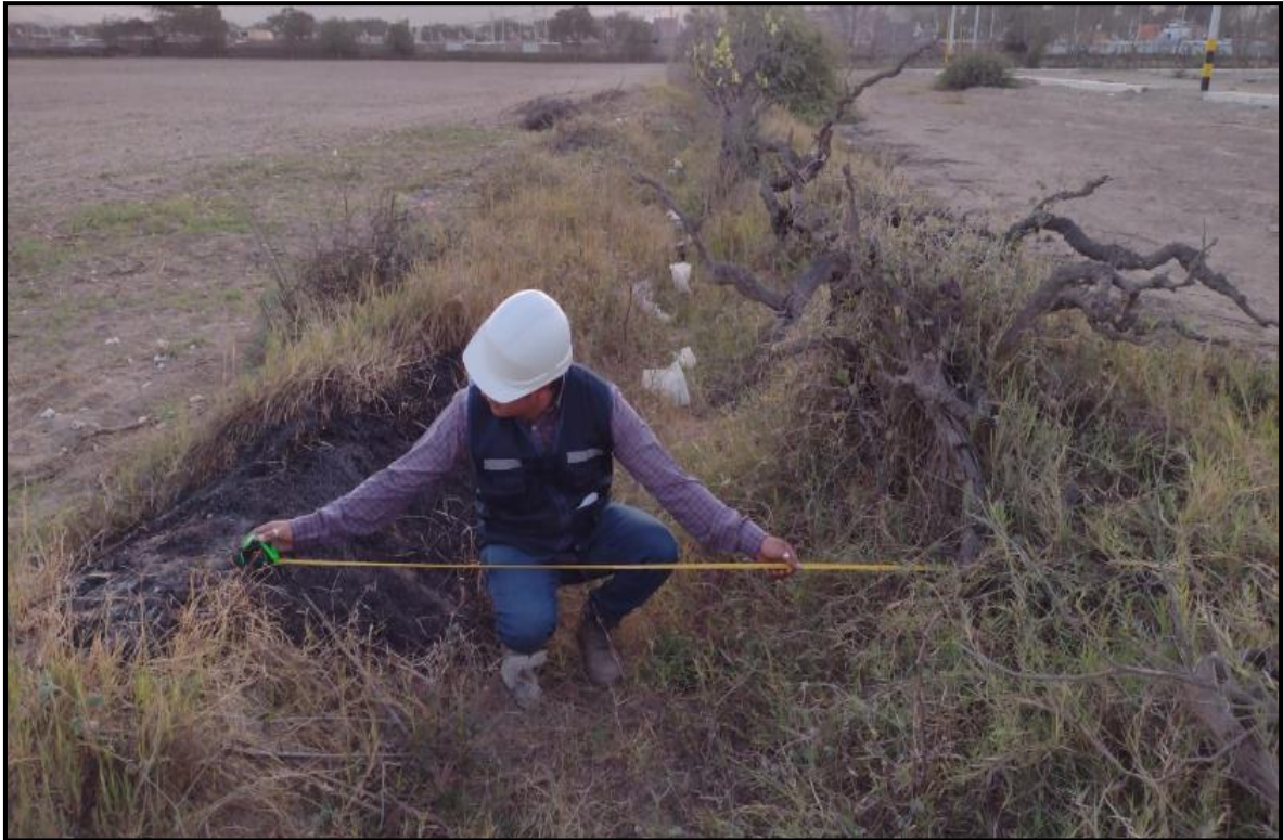
Figura.42 Toma de medida de las secciones del canal, aproximadamente sección de 1.92m
