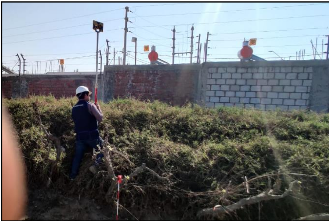
Figura.45 Toma de puntos con el prisma durante levantamiento topográfico.
