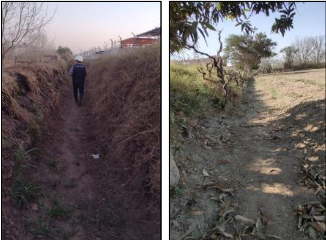
Figura.42 Toma de medida de las secciones del canal, aproximadamente sección de 1.92m
