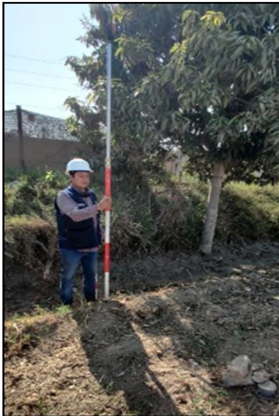
Figura.33 Toma de cotas de terreno y fundacion durante el levantamiento topografico.
