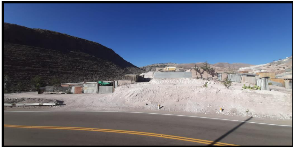
Figura 32: Se muestra la vía de ingreso de la asociación de vivienda los próceres de Torata. Fuente: Elaboración Propia.
