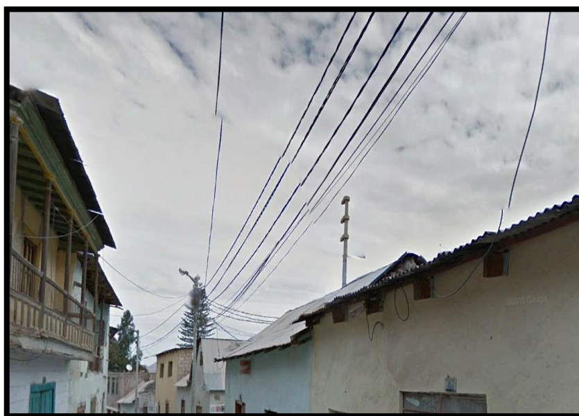
Figura 22: Se muestra los conductores sobre el área de la vivienda. Fuente: Elaboración propia.
