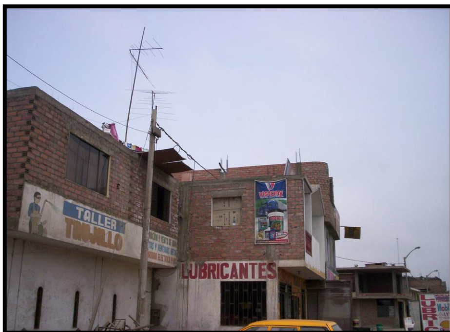
Figura 23: Se muestra la invasión de la vivienda a la propiedad de la vía. Fuente: Ministerio de Energía y Minas en Dirección General de Electricidad.
