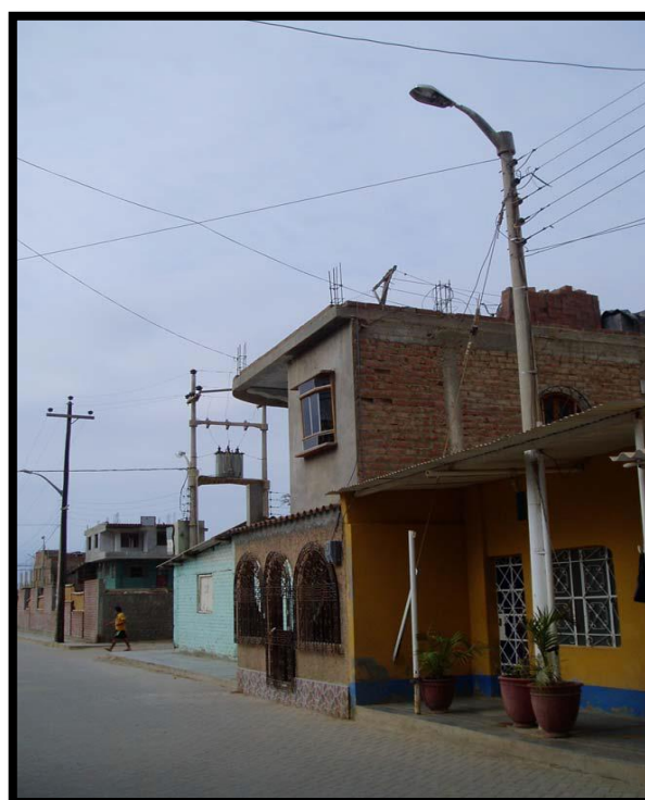
Figura 24: Se muestra la invasión de la vivienda a la propiedad de la vía. Fuente: Ministerio de Energía y Minas en Dirección General de Electricidad.
