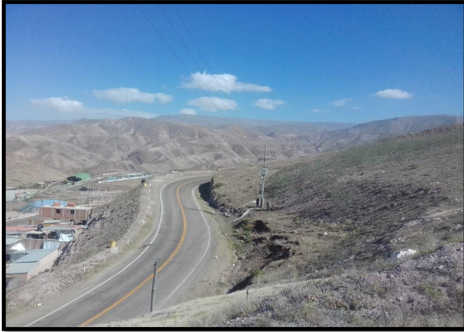
Figura 29: Se muestra la subestación donde se proyectó la alimentación de energía eléctrica de la asociación de vivienda los próceres de Torata.
