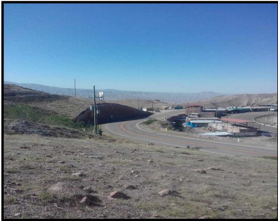
Figura 30: Se muestra la subestación donde se proyectó la alimentación de energía eléctrica de la asociación de vivienda los próceres de Torata.
