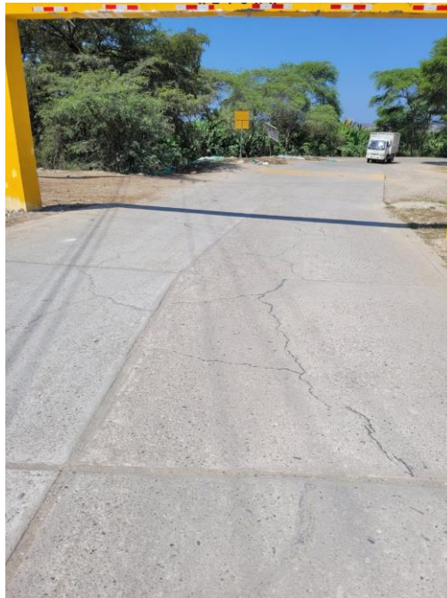
Figura 23: Vista de la obra
