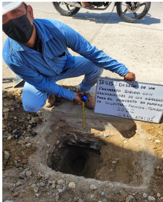
Figura 29: Acercamiento a la calicata C1
