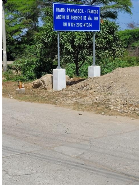
Figura 18: Cartel de la obra en estudio
