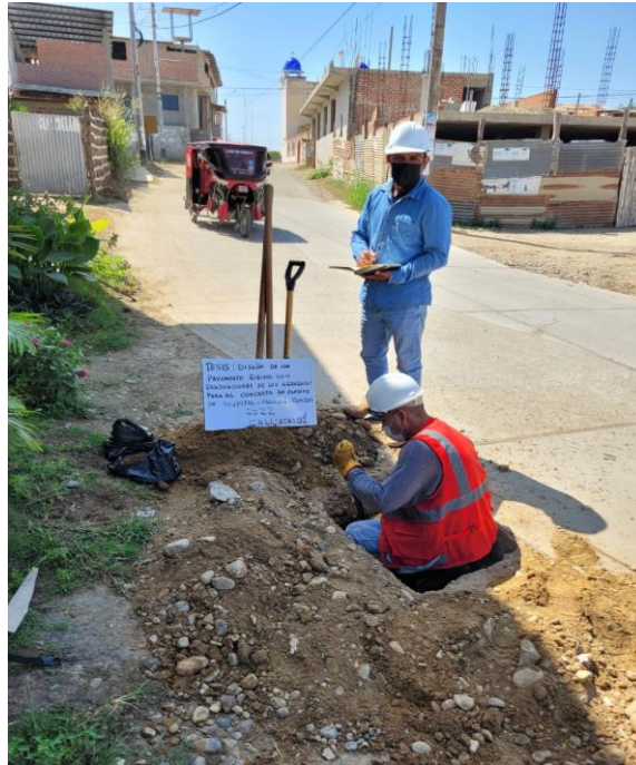
Figura 28: Vista de la calicata 01
