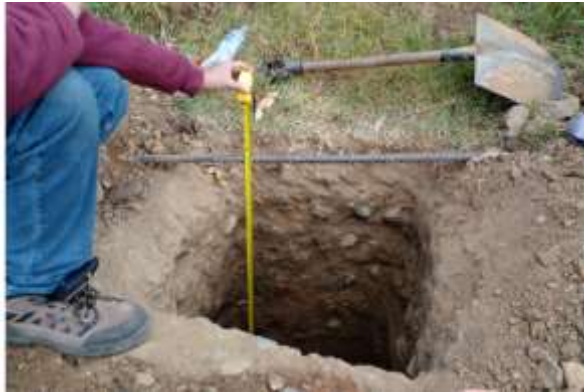
Foto 5. Toma de medida de la profundidad a 1.50 m de la calicata 2
