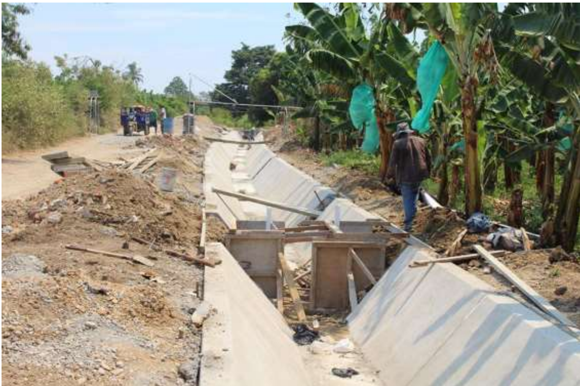
FOTO 21: CONSTRUCCION DE CANALES DE AGUA PARA RIEGO DE LOS CAMPOS DE APPBOSA
