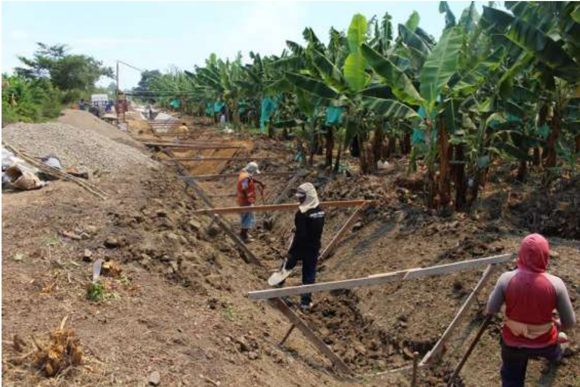
FOTO 20: CONSTRUCCION DE CANALES DE AGUA PARA RIEGO DE LOS CAMPOS DE APPBOSA
