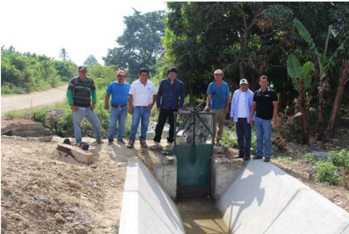
FOTO 23: CONSTRUCCION DE CANALES DE AGUA PARA RIEGO DE LOS CAMPOS DE APPBOSA
