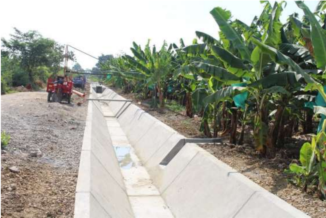
FOTO 22: CONSTRUCCION DE CANALES DE AGUA PARA RIEGO DE LOS CAMPOS DE APPBOSA
