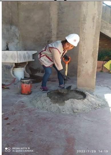
Fotografía 11. Preparación de la mezcla
