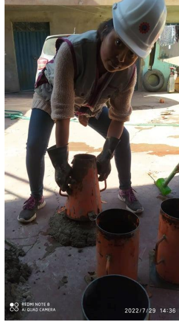
Fotografía 18. Medición del Slump del concreto
