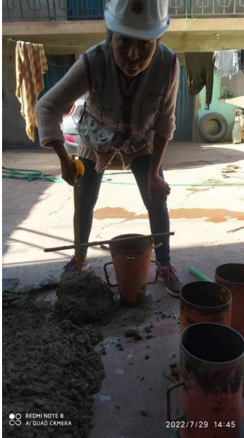
Fotografía 17. Medición del Slump del concreto
