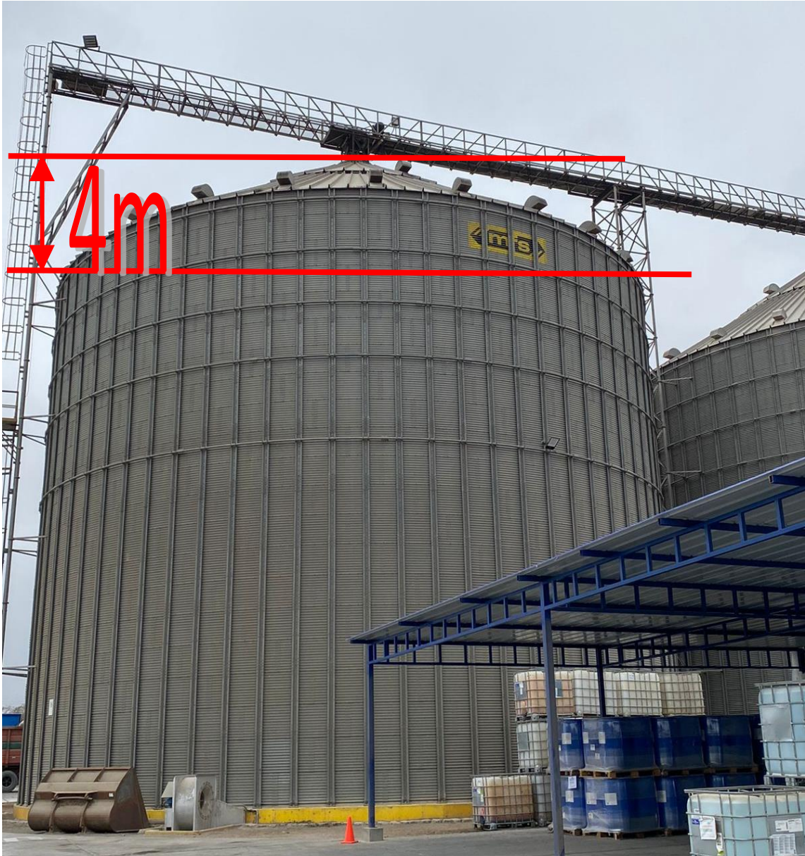
Figura 14: Limitación de altura de cúpula del silo
