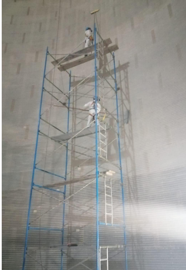
Figura 11: Limpieza del silo
