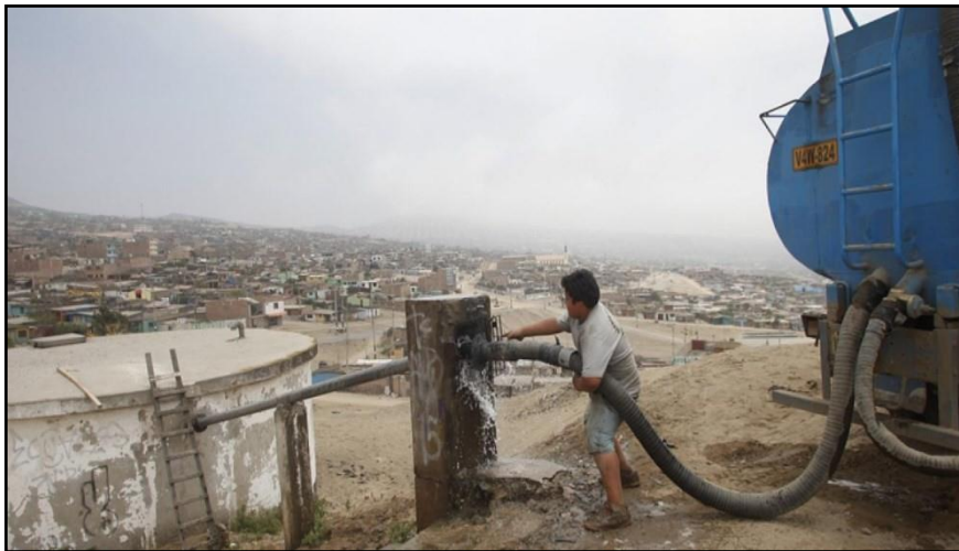
Servicio de agua y saneamiento completamente en abandono - Andina 2022
