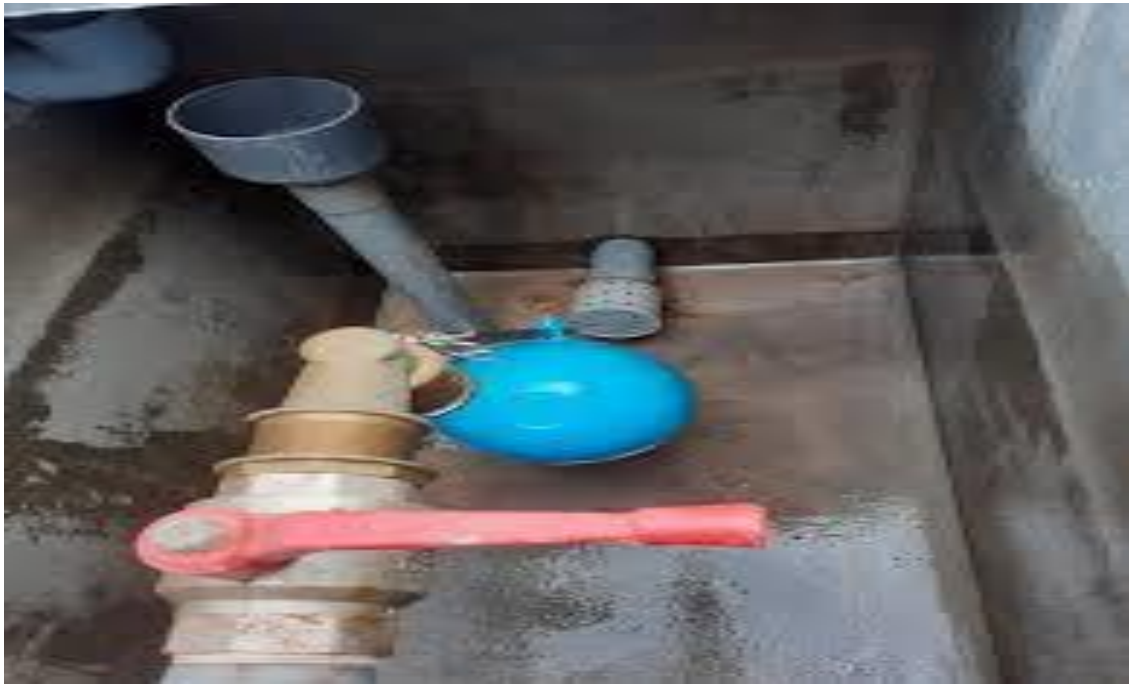
Foto N°04: cámara de ronpepresion
