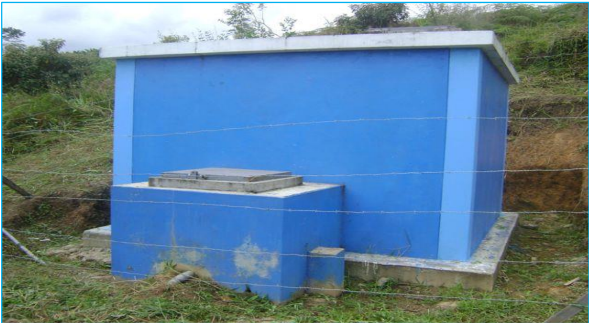
Foto N°06. Reservorio del centro poblado Pichiu Quinhuaragra
