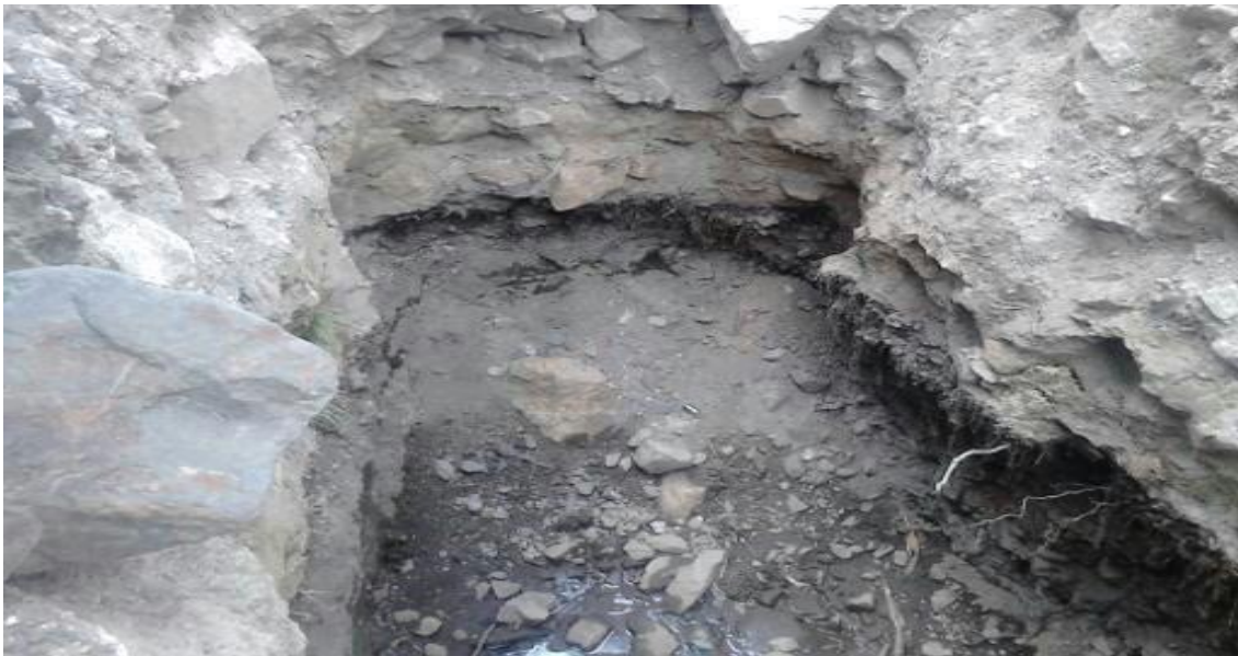
Foto N° 07: Calicata para la realización del estudio de suelos.
