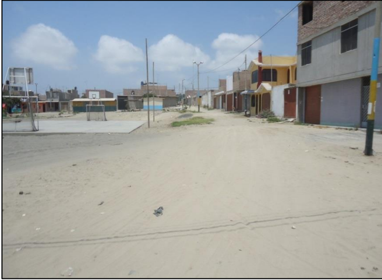
Foto N°16: en esta imagen se muestra que la zona de estudio tiene suelo de fundación arena mal graduada que actúa como suelo blando ante eventos sísmicos, siendo susceptible a provocar deslizamientos o asentamiento, generando fallas en la estructura.
