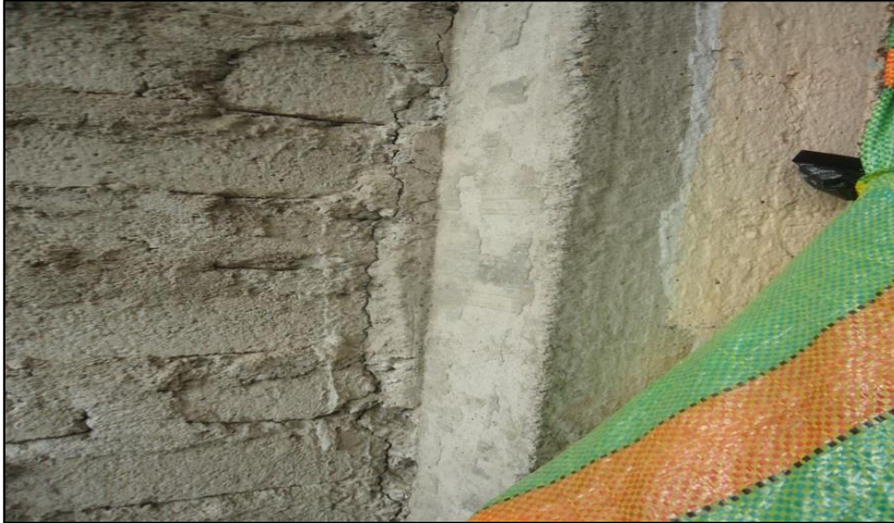
Foto N°04: Se puede ver fisuras en los muros y discontinuidad en las juntas, que tienes dimensiones de más de 3 cms. De espesor, lo cual no permite una buena interacción entre las unidades de albañilería, eso implica vulnerabilidad alta, ítem 2.1 y 2.2.
