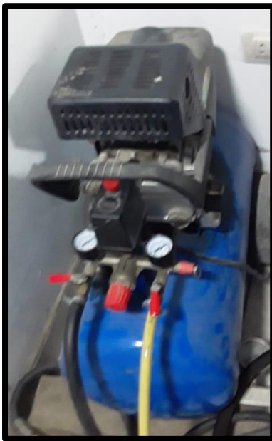
Figura 8. Se adaptó la compresora de aire en el generador de NB.
