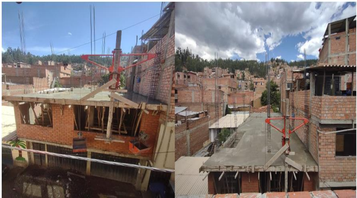
Figura N° 1. Construcción de viviendas en la ciudad de Huaraz
