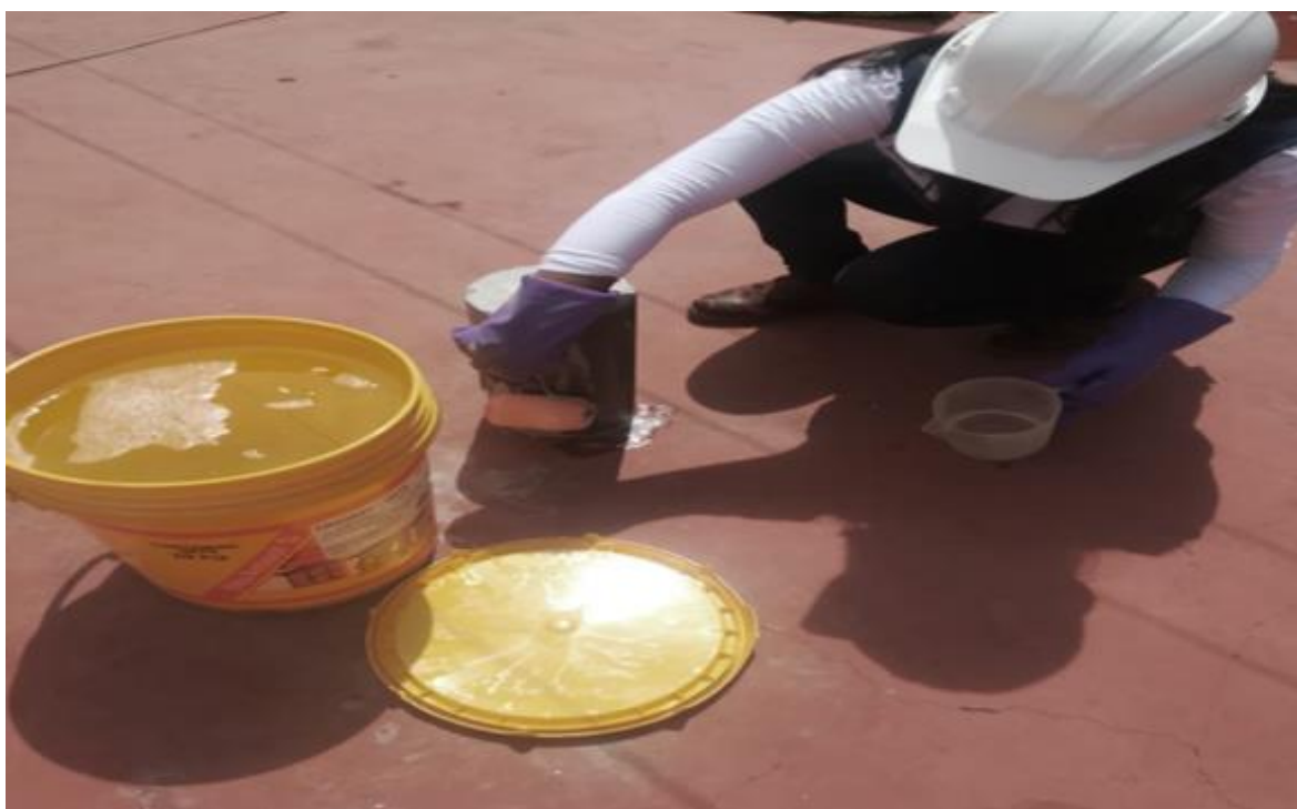
Figura N° 22. Curado de concreto con Sika Antisol S con dos y tres capas.
