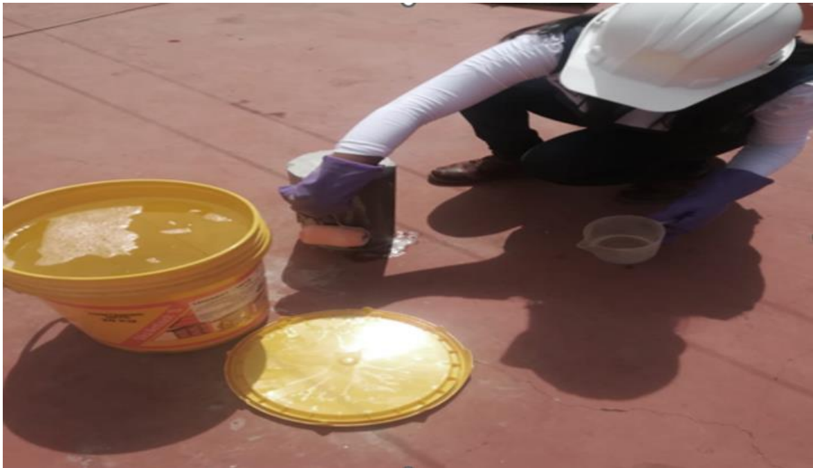
Fotografía N° 7: curado de concreto con dos y tres capas sobre la superficie de las probetas.
