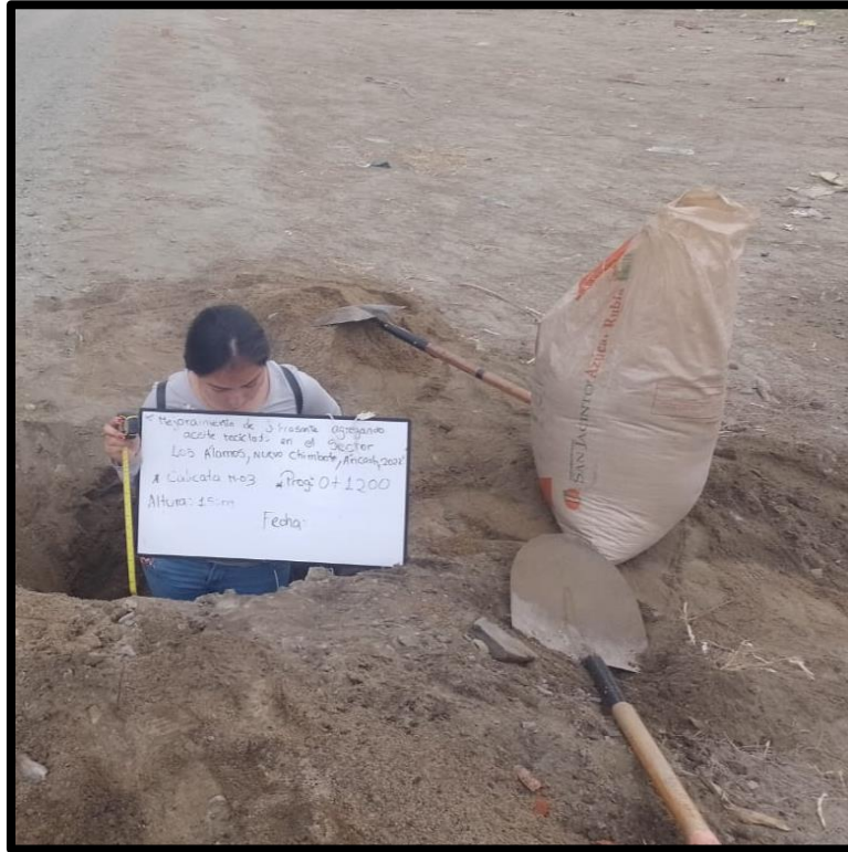
Fotografía 3. Se realizaron las calicatas a una profundidad de 0.50 m a 1.50 m.
