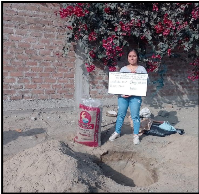
Fotografía 2. Se realizaron las calicatas a una profundidad de 0.50 m a 1.50 m.
