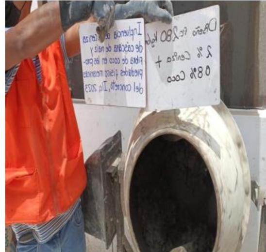
INCORPORACIÓN DE MATERIALES EN LA MEZCLADORA
