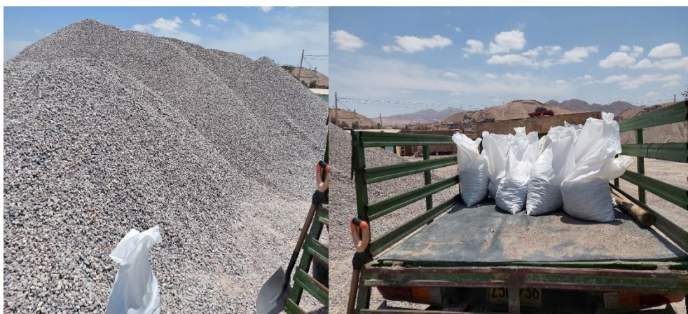
Figura 22. Adquisición de arena gruesa y piedra chancada
