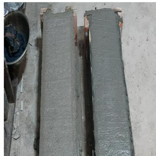
VACIADO DE CONCRETO EN VIGAS
