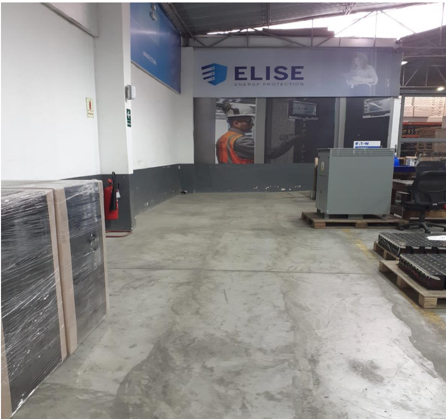
Figura 33: Piso del área de producción mejorado Fuente: ELISE S.A.C.
