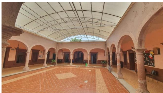
Figura 1: Centro de Rehabilitación San Felipe - México
