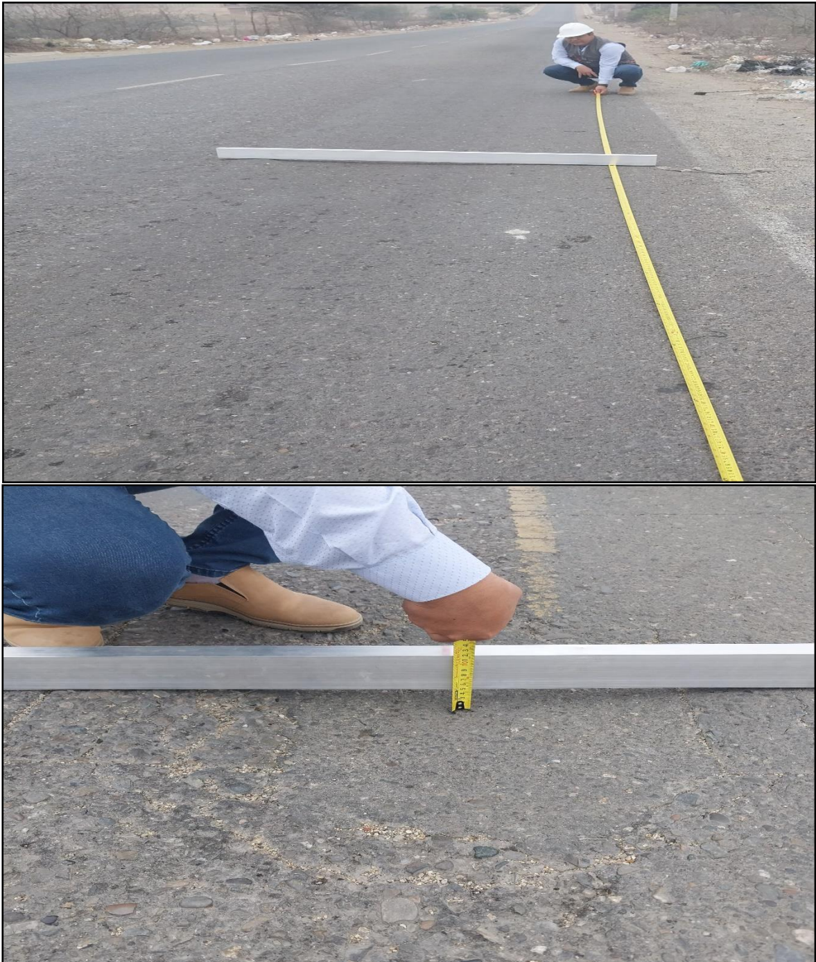
Panel fotográfico: Deterioros analizados Sección 15
