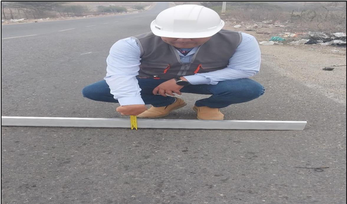
Panel fotográfico: Deterioros analizados Sección 2
