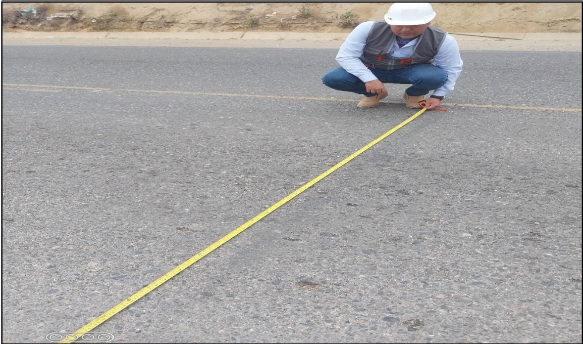
Panel fotográfico: Deterioros analizados Sección 5
