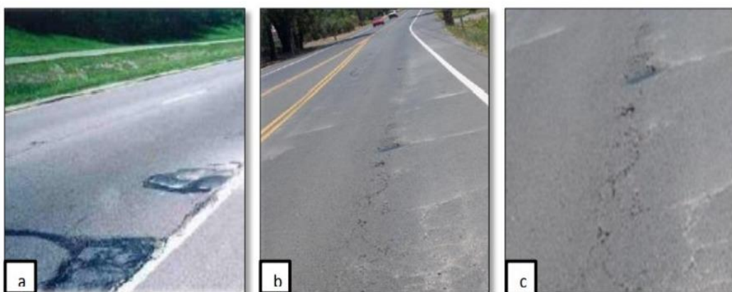
Figura 20: Afloramiento de mortero – Tipo B
