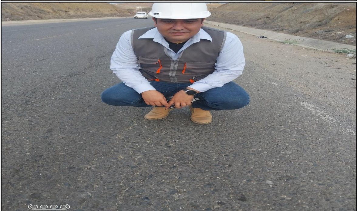
Panel fotográfico: Deterioros analizados Sección 20
