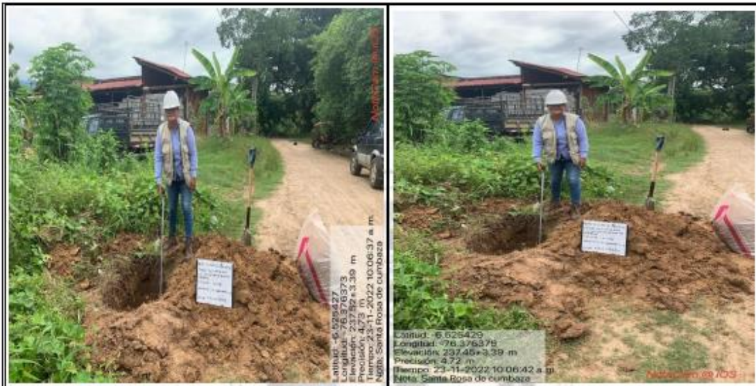
Fotos N° 21-22: En las imágenes podemos observar Calicata N° 05.
