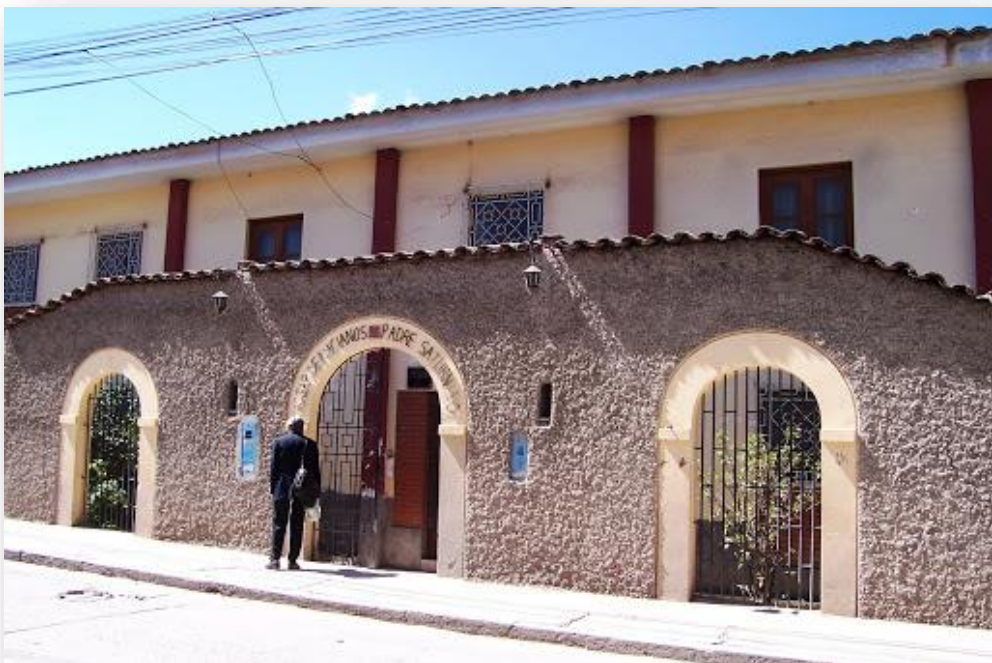
Figura N° 2: Asilo de ancianos-parte exterior
