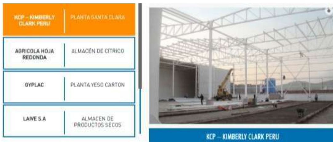
Figura 16. Ejecución de proyectos industriales
