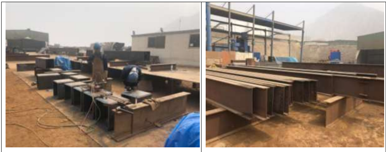
Figura 29. Operarios ejecutando el nuevo método de trabajo implantado
