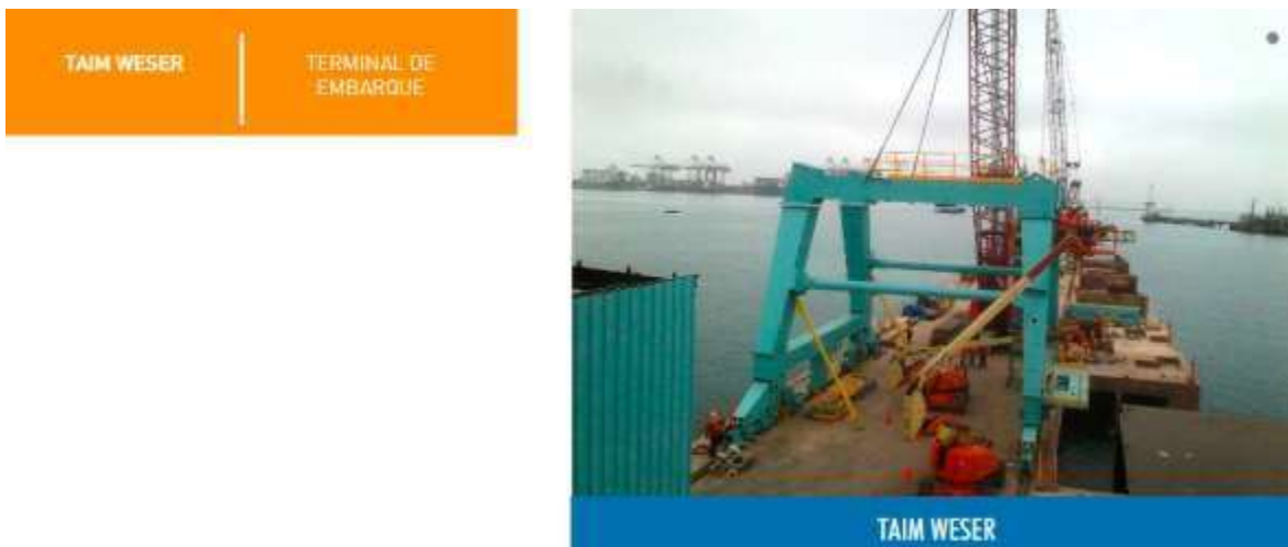
Figura 21. Ejecución de otros proyectos
