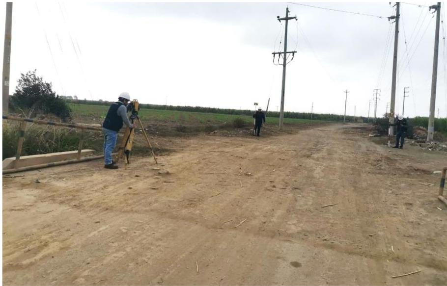
**FOTOGRAFIA N°03:** LEVANTAMIENTO TOPOGRAFICO DEL TRAMO SINTUCO – MONCADA ALTA, DESDE LA PROGRESIVA 0+000 KM AL 13+577 KM.
