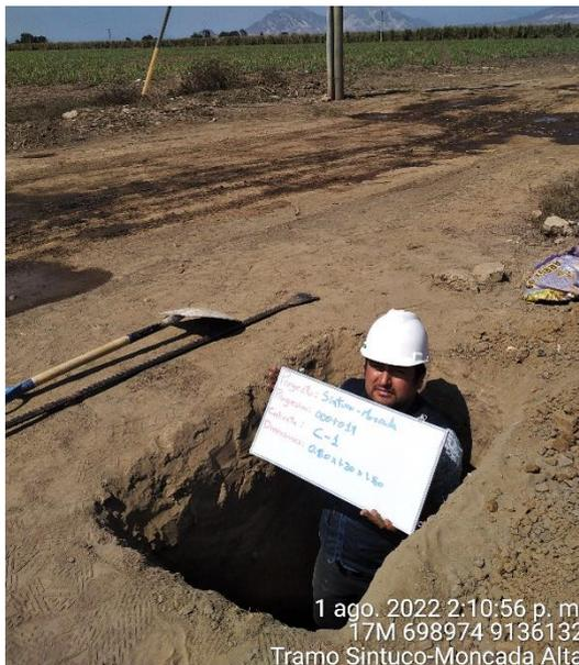
**FOTOGRAFIA N°15:** EXCAVACIÓN DE LA CALICATA N°01 EN LA PROGRESIVA KM 0+140 DE DIMENSIONES 1.20 x 0.80 x 1.50m
