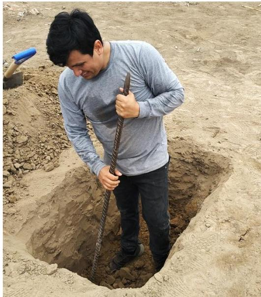
**FOTOGRAFIA N°14: EXCAVACIÓN DE CALICATAS DE 1.20 x 0.80 x 1.50m**
