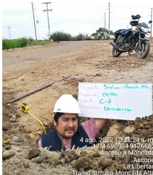
**FOTOGRAFIA N°20:** EXCAVACIÓN DE LA CALICATA N°06 EN LA PROGRESIVA KM 13+000 DE DIMENSIONES 1.20 x 0.80 x 1.50m
