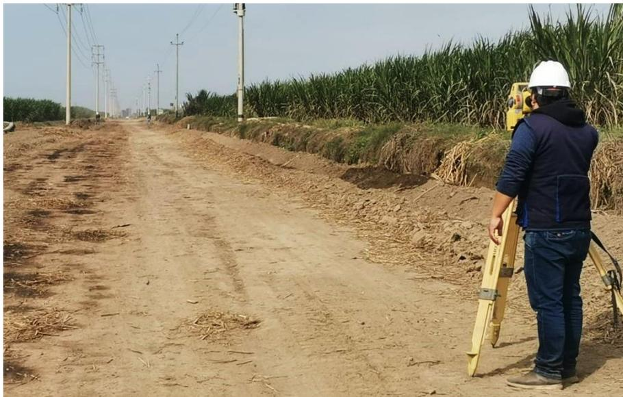
**FOTOGRAFIA N°06:** LEVANTAMIENTO TOPOGRAFICO DEL TRAMO SINTUCO – MONCADA ALTA, DESDE LA PROGRESIVA 0+000 KM AL 13+577 KM.
