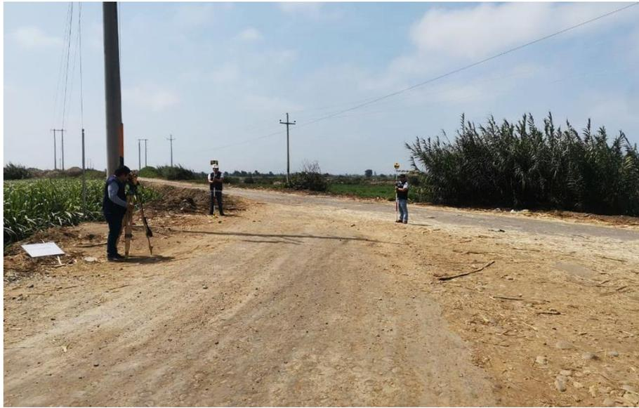
**FOTOGRAFIA N°11:** LEVANTAMIENTO TOPOGRAFICO DEL TRAMO SINTUCO – MONCADA ALTA, DESDE LA PROGRESIVA 0+000 KM AL 13+577 KM.
