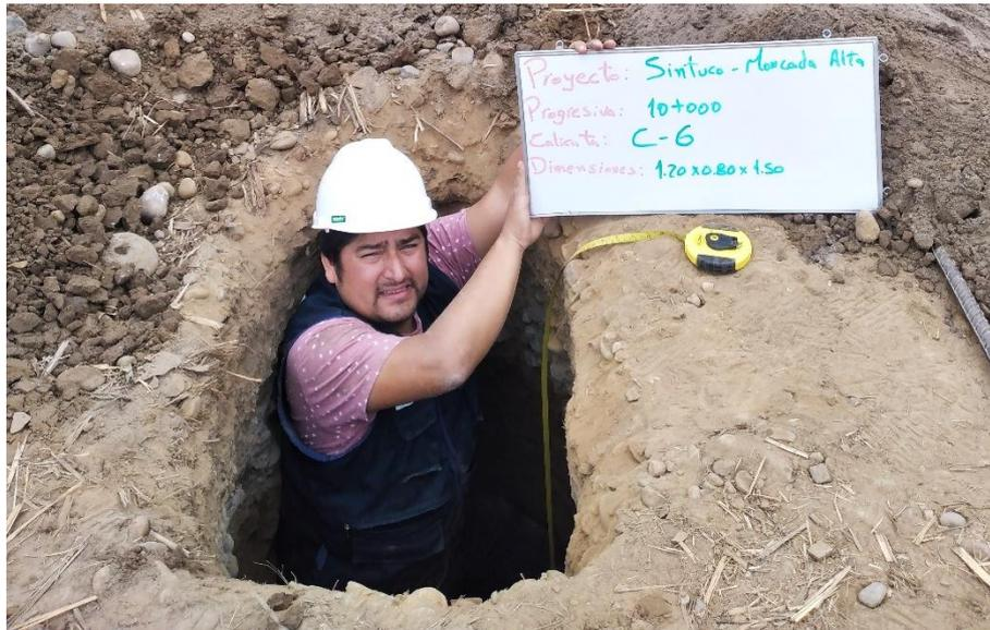
**FOTOGRAFIA N°19:** EXCAVACIÓN DE LA CALICATA N°05 EN LA PROGRESIVA KM 10+000 DE DIMENSIONES 1.20 x 0.80 x 1.50m
