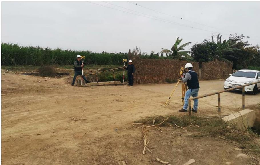
**FOTOGRAFIA N°02:** LEVANTAMIENTO TOPOGRAFICO DEL TRAMO SINTUCO – MONCADA ALTA, DESDE LA PROGRESIVA 0+000 KM AL 13+577 KM.
