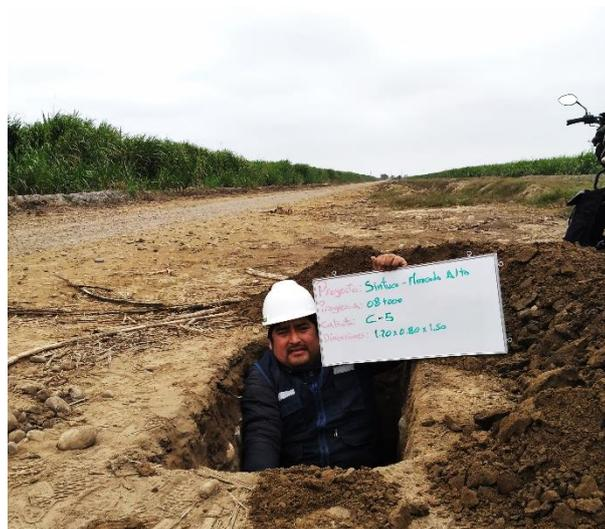
**FOTOGRAFIA N°18: EXCAVACIÓN DE LA CALICATA N°04 EN LA PROGRESIVA KM 8+000 DE DIMENSIONES 1.20 x 0.80 x 1.50m**
