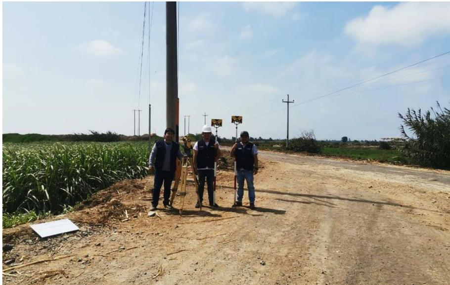
**FOTOGRAFIA N°12:** LEVANTAMIENTO TOPOGRAFICO DEL TRAMO SINTUCO – MONCADA ALTA, DESDE LA PROGRESIVA 0+000 KM AL 13+577 KM.
