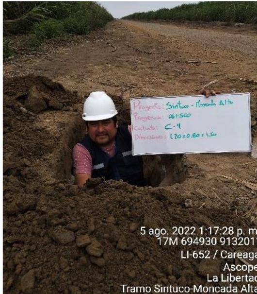
**FOTOGRAFIA N°17: EXCAVACIÓN DE LA CALICATA N°03 EN LA PROGRESIVA KM 6+500 DE DIMENSIONES 1.20 x 0.80 x 1.50m**
