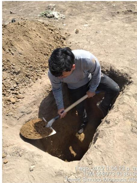
**FOTOGRAFIA N°13: EXCAVACIÓN DE CALICATAS DE 1.20 x 0.80 x 1.50m**
