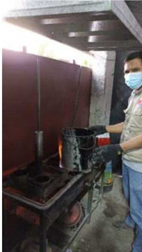
Calentamiento del asfalto
