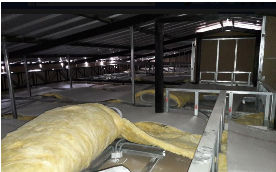
Trabajos sobre tableros eléctricos por Tecnergy (2017)
