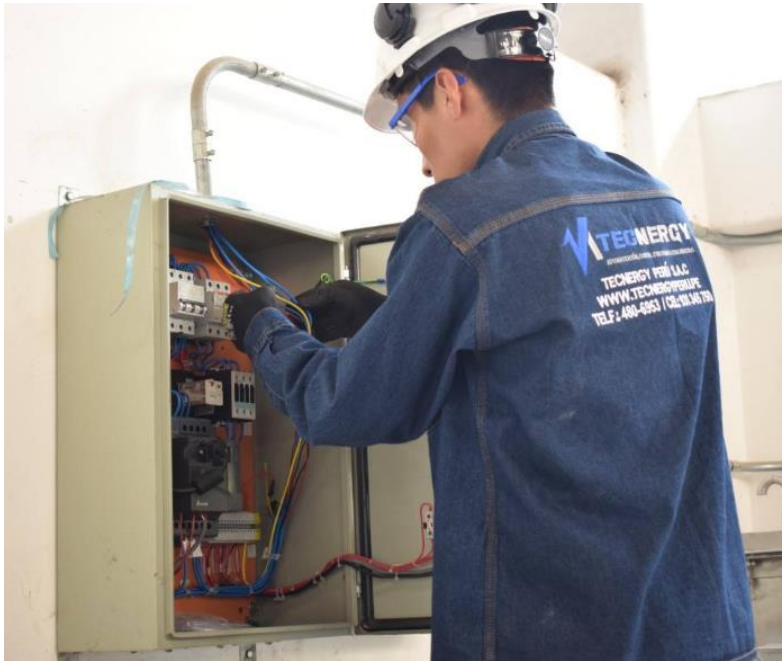
Trabajos en tableros eléctricos realizado por Tecnergy (2017)
