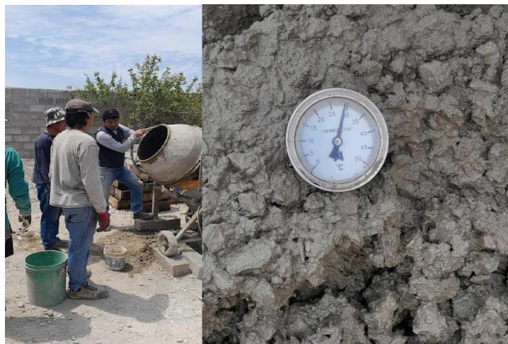
Figura 8. Verificación de la preparación y Temperatura del concreto fresco
