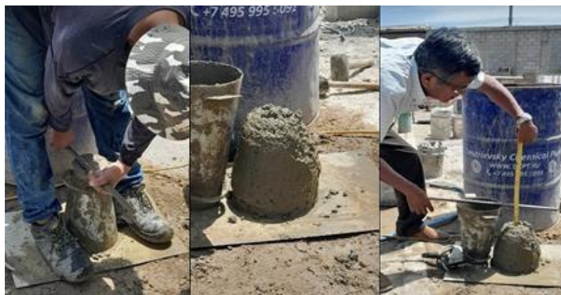
Figura 7. Verificación del Asentamiento del Concreto a través del SLUMP
