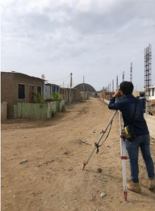
**Figura 2.** Realización del levantamiento topográfico
