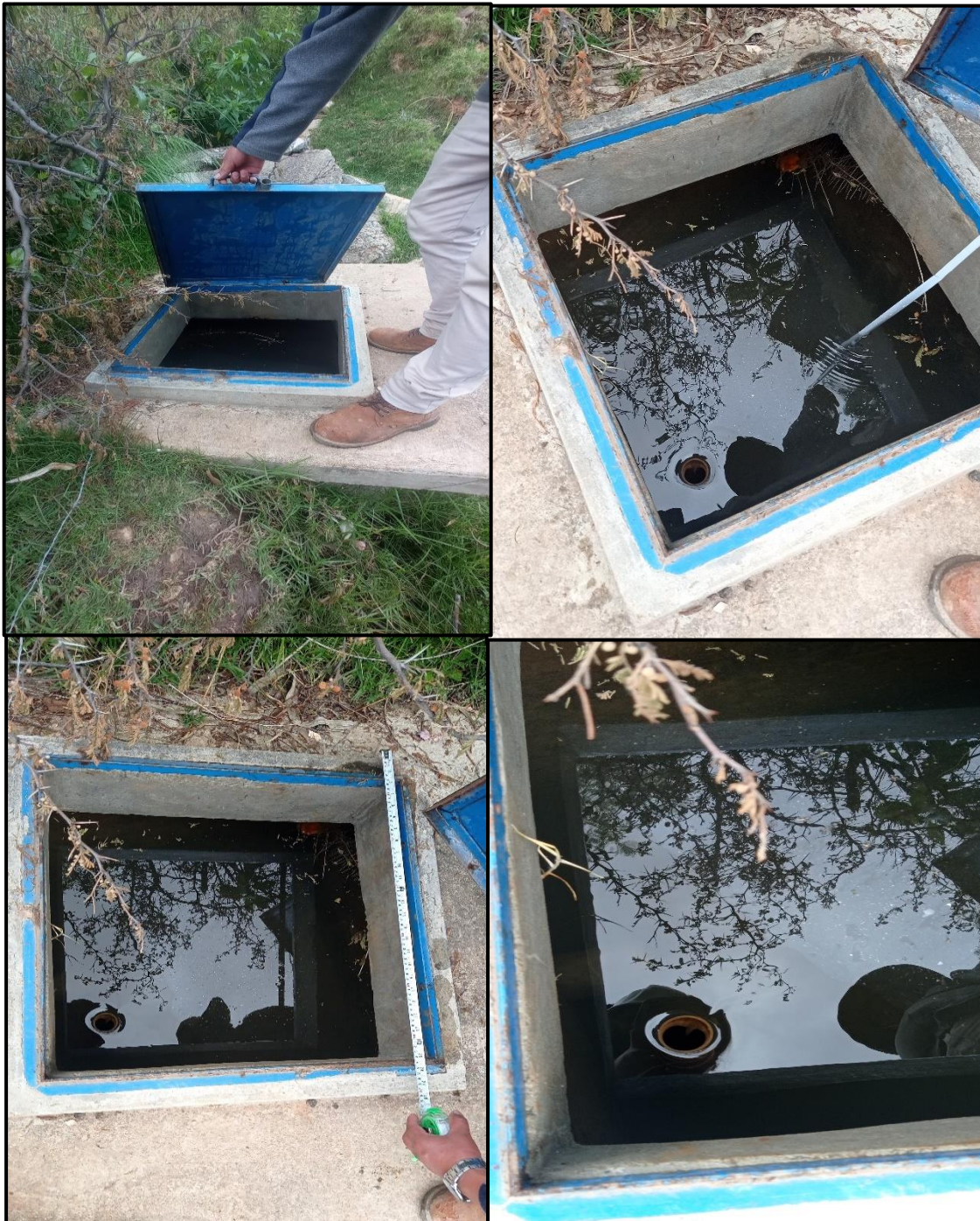
Figura N° 23: Evaluación de Características de la Estructura de la Captación N° 01
