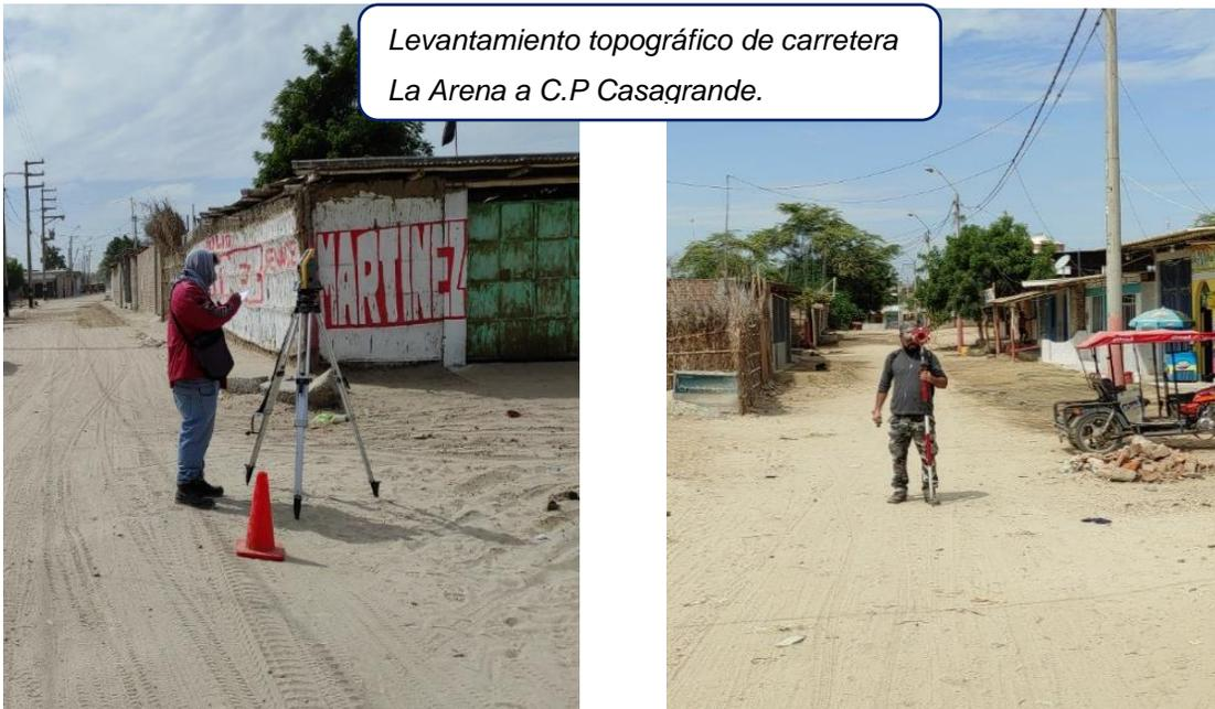
Figura 8 Levantamiento topográfico de carretera La Arena a C.P Casagrande
