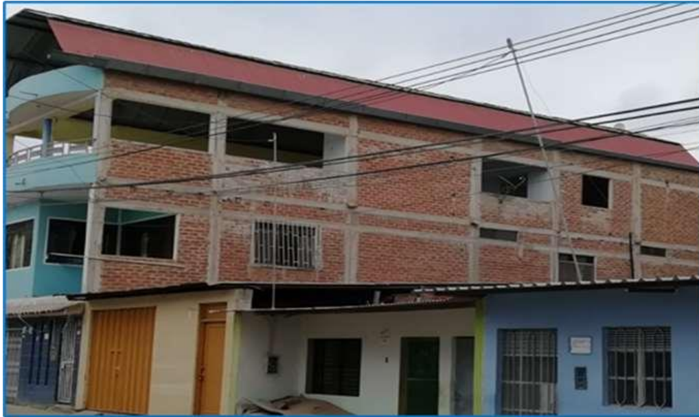
Figura 9: edificación C-5 con buena calidad del sistema resistente. Se observa la ortogonalidad de las columnas y vigas. El entramado es parejo y bien logrado. Se calificó con A en este parámetro
