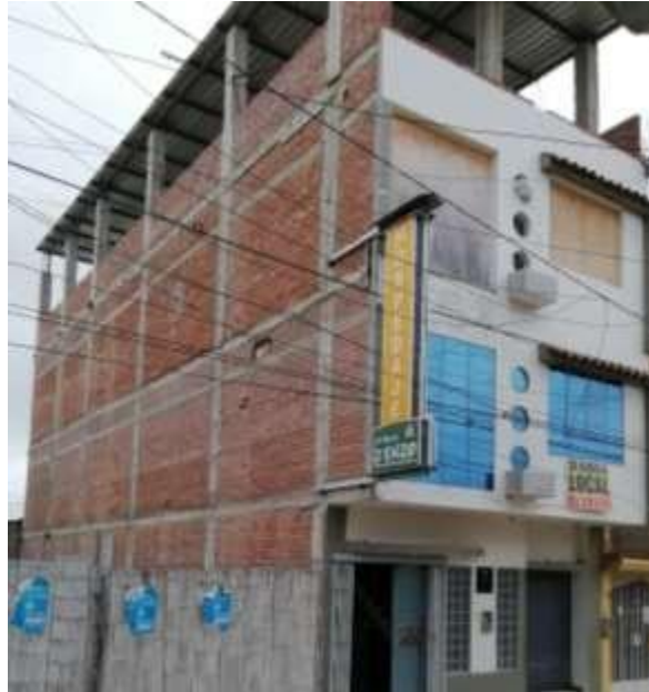
Figura 15: en la edificación C-4 los diafragmas se aprecian completos, uniformes y bien logrados. Calificación A Fuente: propia
