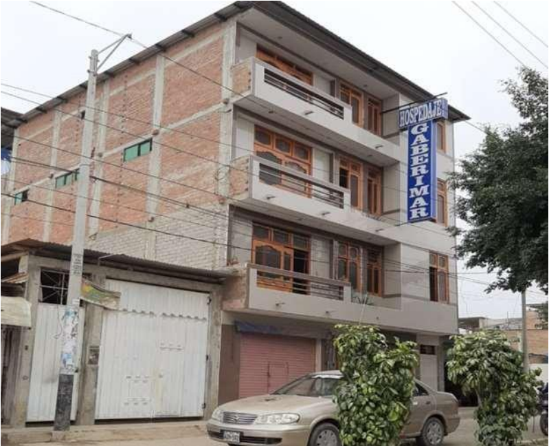
Figura 31: muestra de una edificación (C-2) en buen estado de conservación
