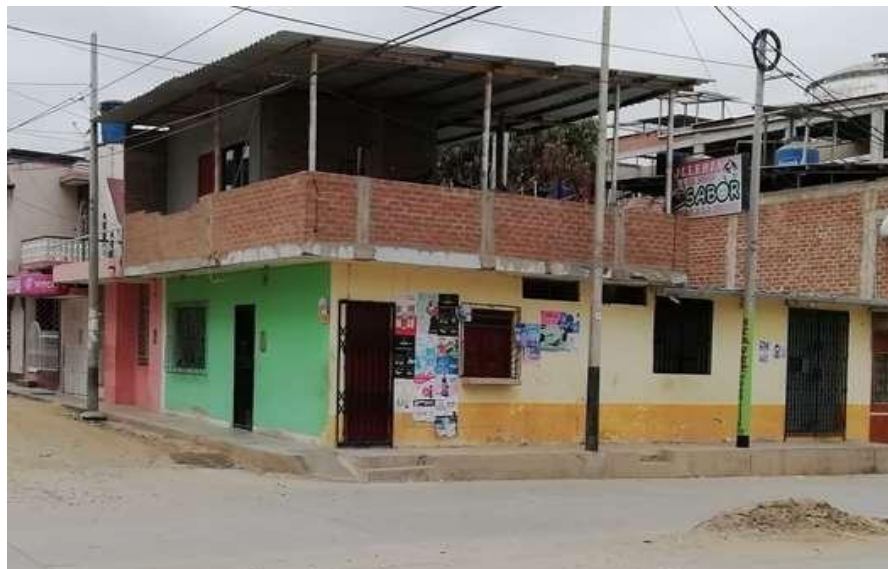
Figura 16: edificación C-14 donde el diafragma no abarca la totalidad del 1er piso. Se le calificó con D Fuente: propia
