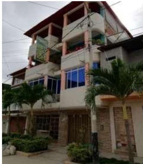
Figura 28: edificación C-9 con maceteros en el parapeto del 3er nivel. Calificación D Fuente: propia
