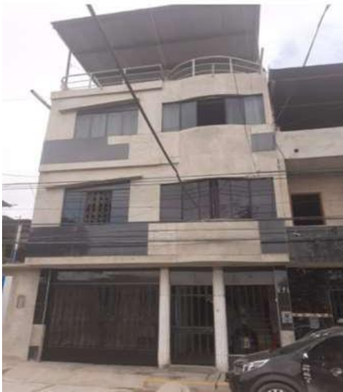
Figura 25: edificación C-8 con cubierta en buen estado Fuente: propia
