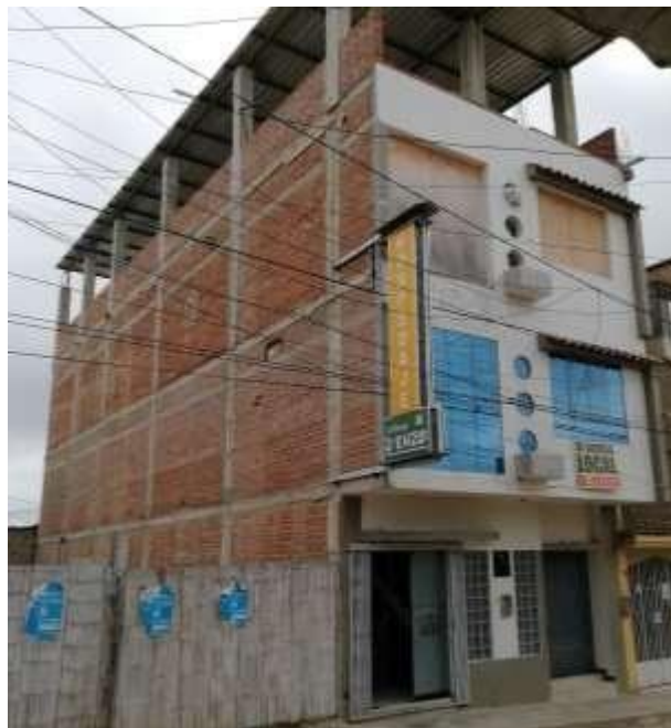
Figura 13: edificación C-4 sin aparentes irregularidades en planta o altura
