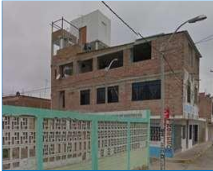
Figura 6: fotografía que muestra un estadio del proceso constructivo de la edificación C-15. Se observan los muros riostras transversales y los confinamientos del momento. No hay problemas visibles de fallas en el proceso constructivo. Se evaluó con A para este parámetro
