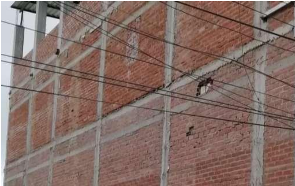
Figura 23: acercamiento en la edificación C-4 no muestra muros transversales trabados en la pared lateral, infiriéndose que aquellos se encuentran únicamente en las columnas, resultandos escasos en número. Calificó con D para este parámetro
