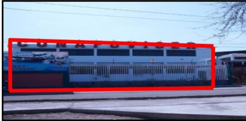
Fachada principal muestra simetría con un volumen a doble altura en el volumen en forma de paralelepípedo trunco continuo a otro generando volúmenes macizos
