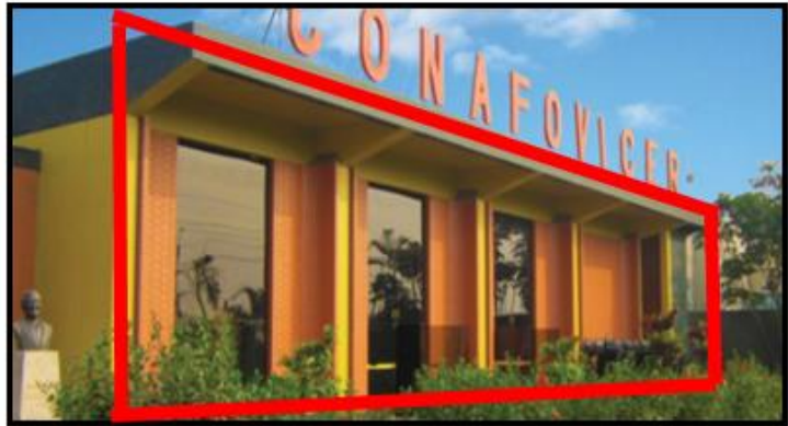
Fachada principal muestra simetría con un volumen a doble altura en el volumen en forma de paralelepípedo trunco continuo a otro generando volúmenes macizos
