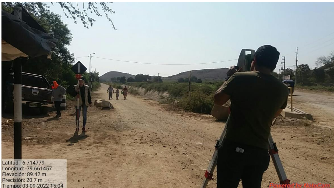
Figura 18 Levantamiento Topográfico en el cruce de Conchucos – Fala Falita con Carretera Batangrande.
