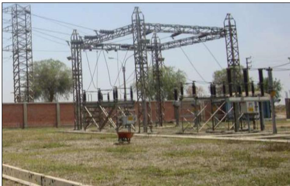
**Figura 24.** Seccionador llegada línea 2 y pórtico de barraje
