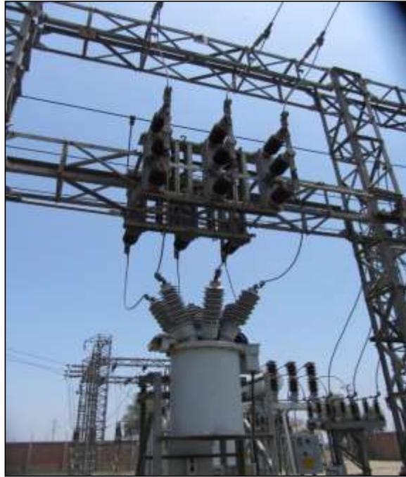
**Figura 28.** Bahías salidas de línea 22,9Kv
