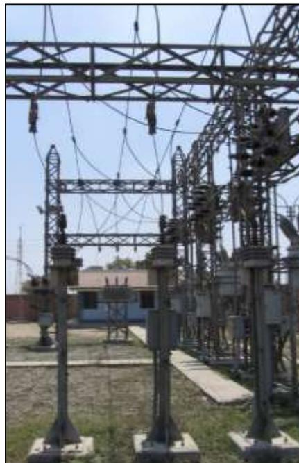
**Figura 29.** Transformador de tensión barras 22,9Kv
