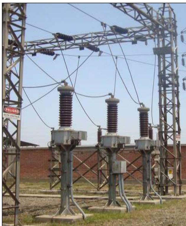
**Figura 25.** Transformadores de tensión barras 60Kv
