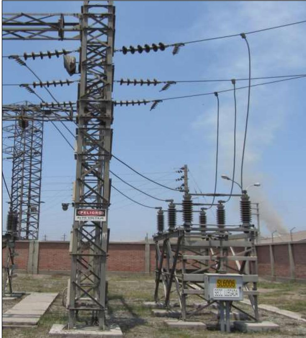
**Figura 23.** Seccionadora llegada de línea 1
