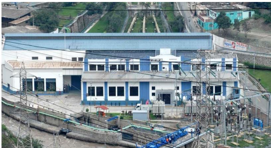
Figura 3. Central Hidroeléctrica Callahuanca Vista Frontal.
