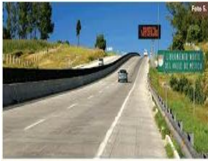
Figura 1. Pavimento rígido
