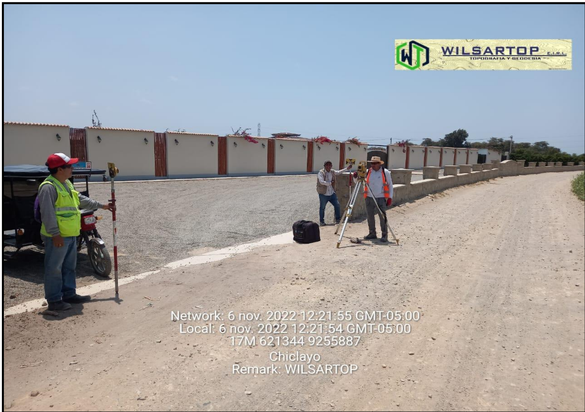
Figura 21. Labores de levantamiento topográfico Dren 2000 – Distrito San José 1
