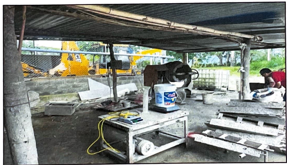
Proceso de fabricación de los ladrillos, en distintas proporciones de adición de fibra de bambú, y muestras patrones utilizando la mesa vibradora.
