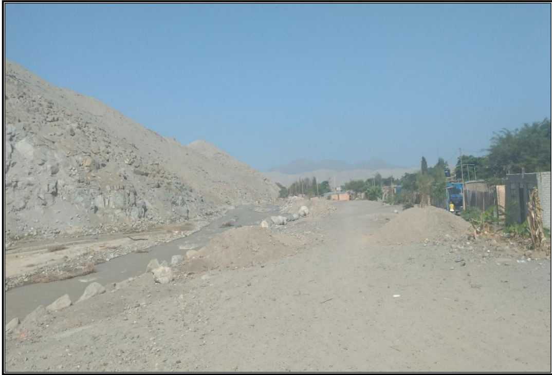
Imagen N°9: Vista de dique de protección con material propio del margen derecho del río, y ubicación de viviendas que están dentro de las franjas marginales.
