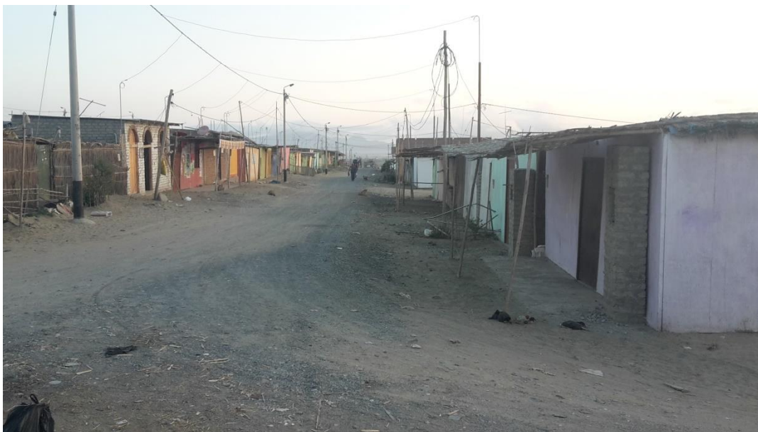
FOTOGRAFIA 01: Se observa las viviendas del Asentamiento Humano Vista al Mar II.
