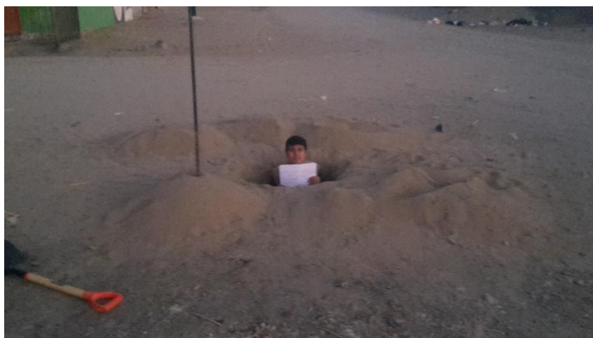
FOTOGRAFIA 04: Se realizó 08 calicatas en el asentamiento humano Vista al Mar II a profundidades de 1.60, 1.70, 1.80 y 1.90m respectivamente.
