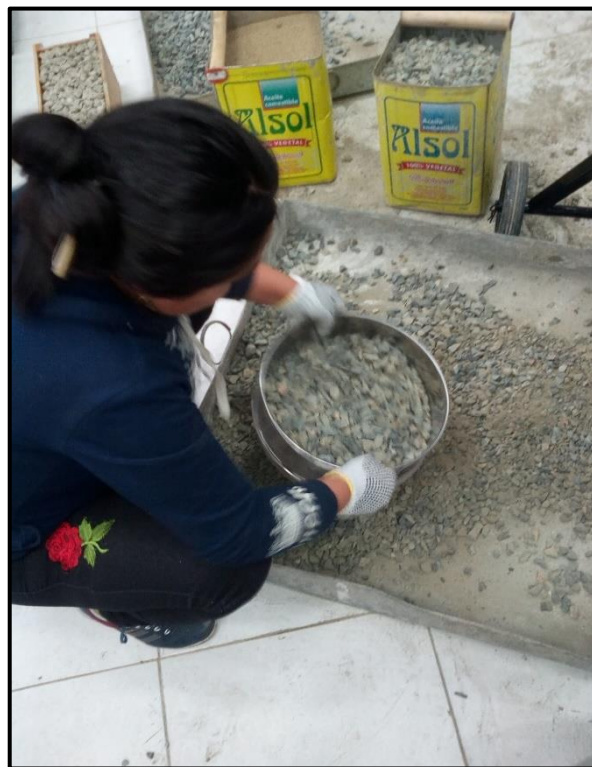
FOTO N°10: Vista de los trabajos de zarandeo del material grueso, para seleccionar piedra de ½”.
