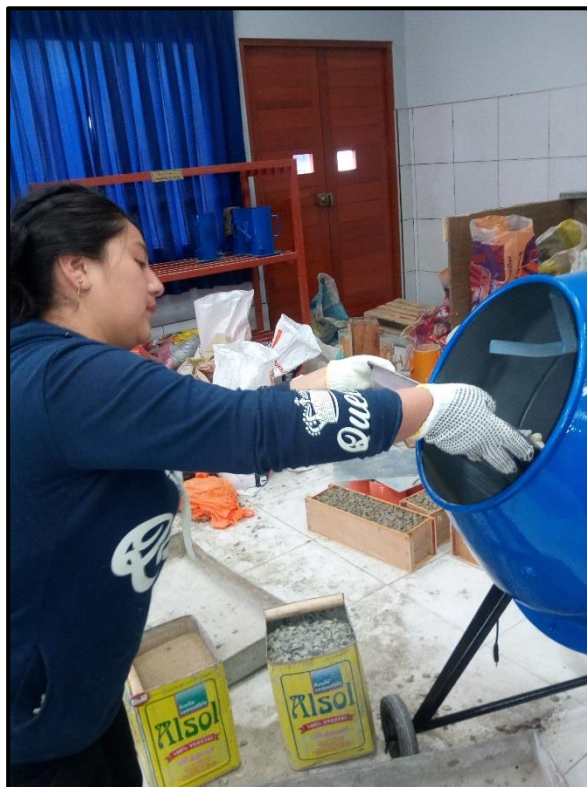
FOTO N°16: Vista de los trabajos de la elaboración de la mezcla.
