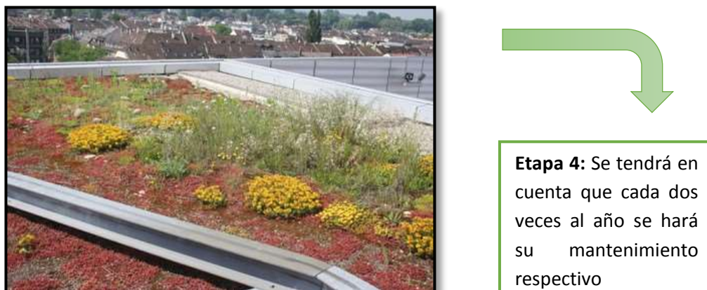
Figura 14 Procedimiento de instalación – Mantenimiento
