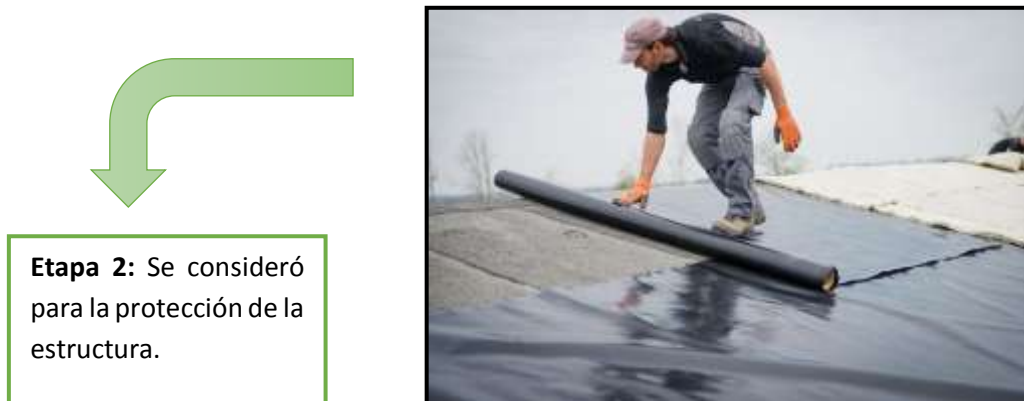
Figura 9 Procedimiento de instalación – Manta Asfáltica
