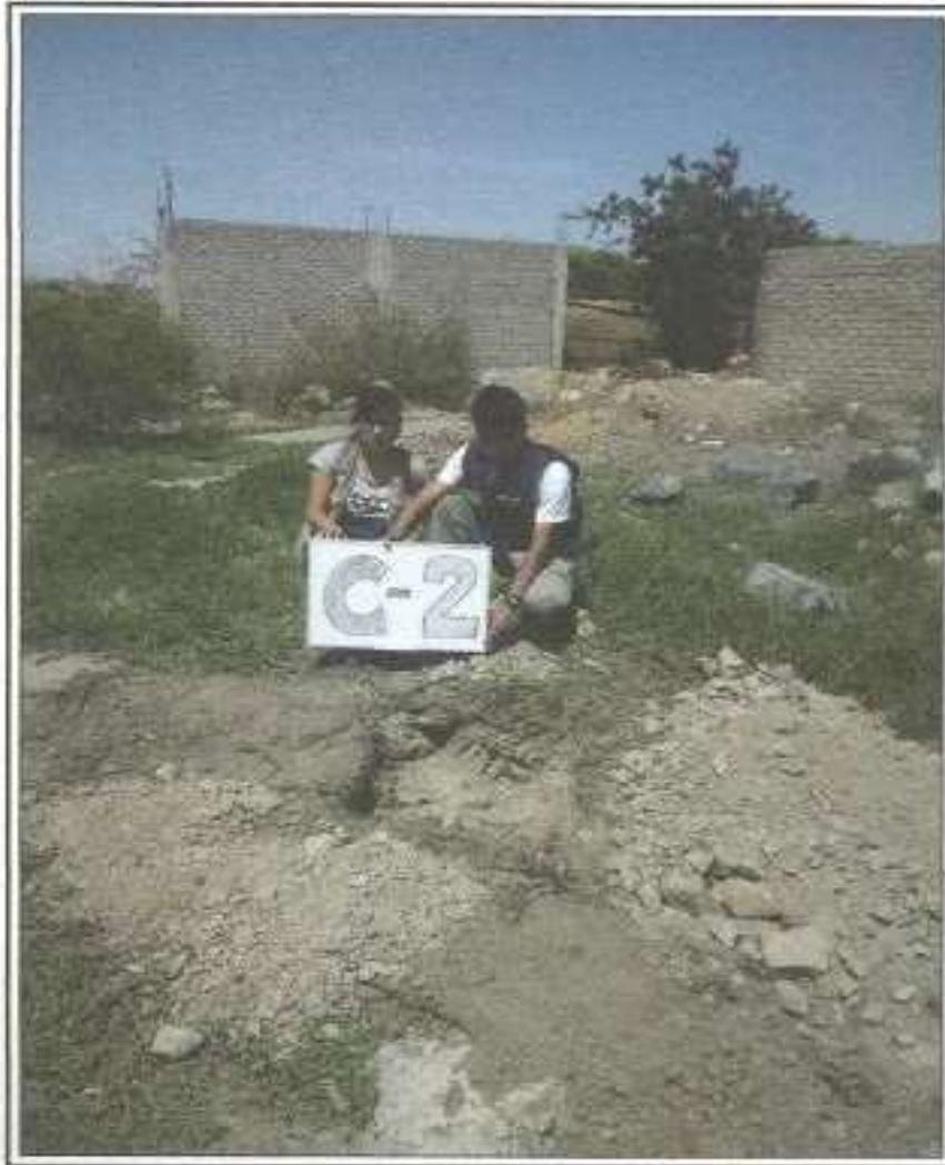
Foto N° 2: Vista panorámica de la Calicata C - 2.
