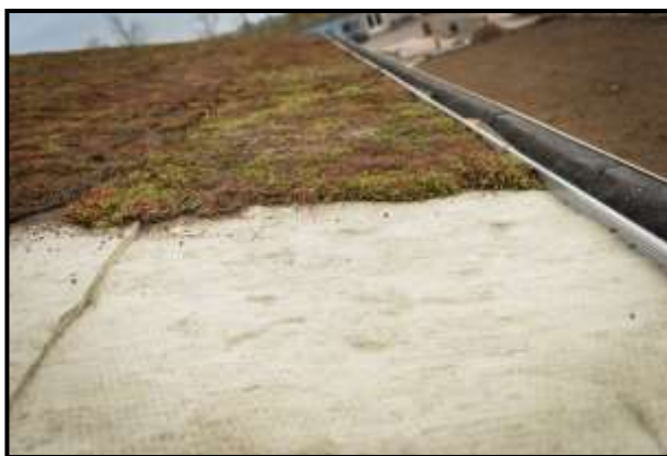
Figura 12 Procedimiento de instalación – Sustrato
