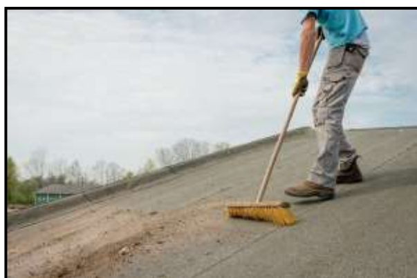
Figura 8 Procedimiento de instalación - Limpieza
