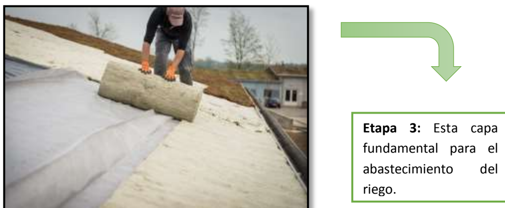
Figura 10 Procedimiento de Instalación - Drenaje
