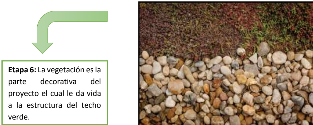
Figura 13 Procedimiento de instalación – Especies vegetales
