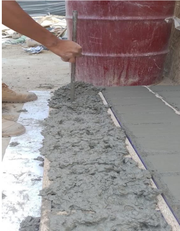
Figura 19: vaciado de moldes de 20 cm x 10cm x 8cm
