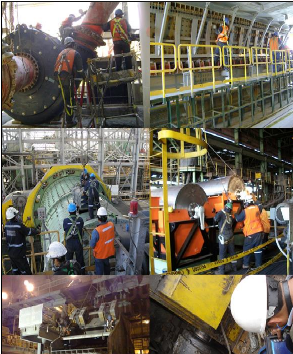
Figura 2. Trabajos de la empresa PICOFAM SAC Fuente: empresa PICOFAM
