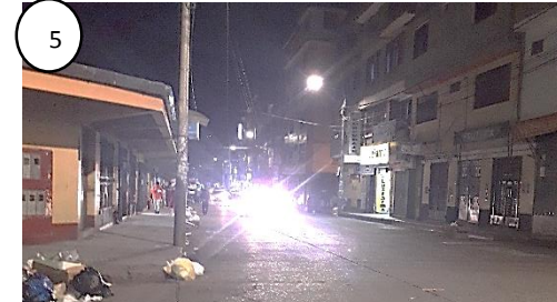
Estructura de la calle del jirón Juan de la Cruz Romero
