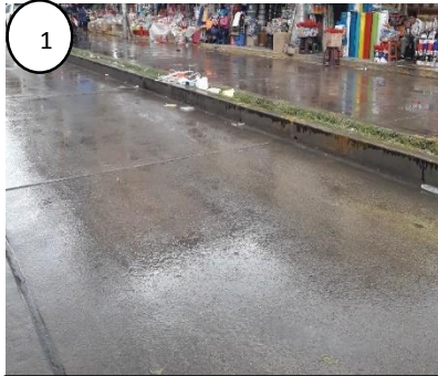
Pista de Jirón Hualcan en buen estado
