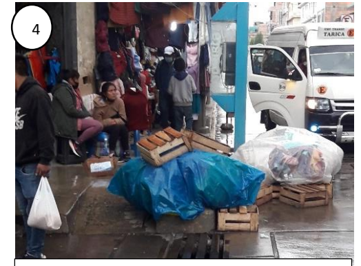
Rampa del Jirón Hualcan obstruida una parte por productos de la actividad comercial.
