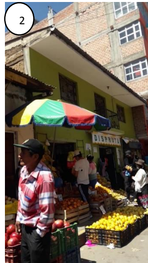
Vivienda que cuenta con alero y canaleta de recibo de agua fluvial, pero la tubería converge hacia el espacio público y la vereda ocupada por productos comerciales
