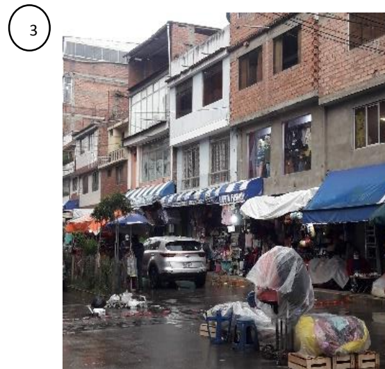
Viviendas que cuentan con azoteas sin y con cobertura pero con poca inclinación, no cuentan con canaletas, pero sobresalen de estas la tubería de agua hacia el espacio público y las veredas ocupadas por comerciantes informales ambulorios
